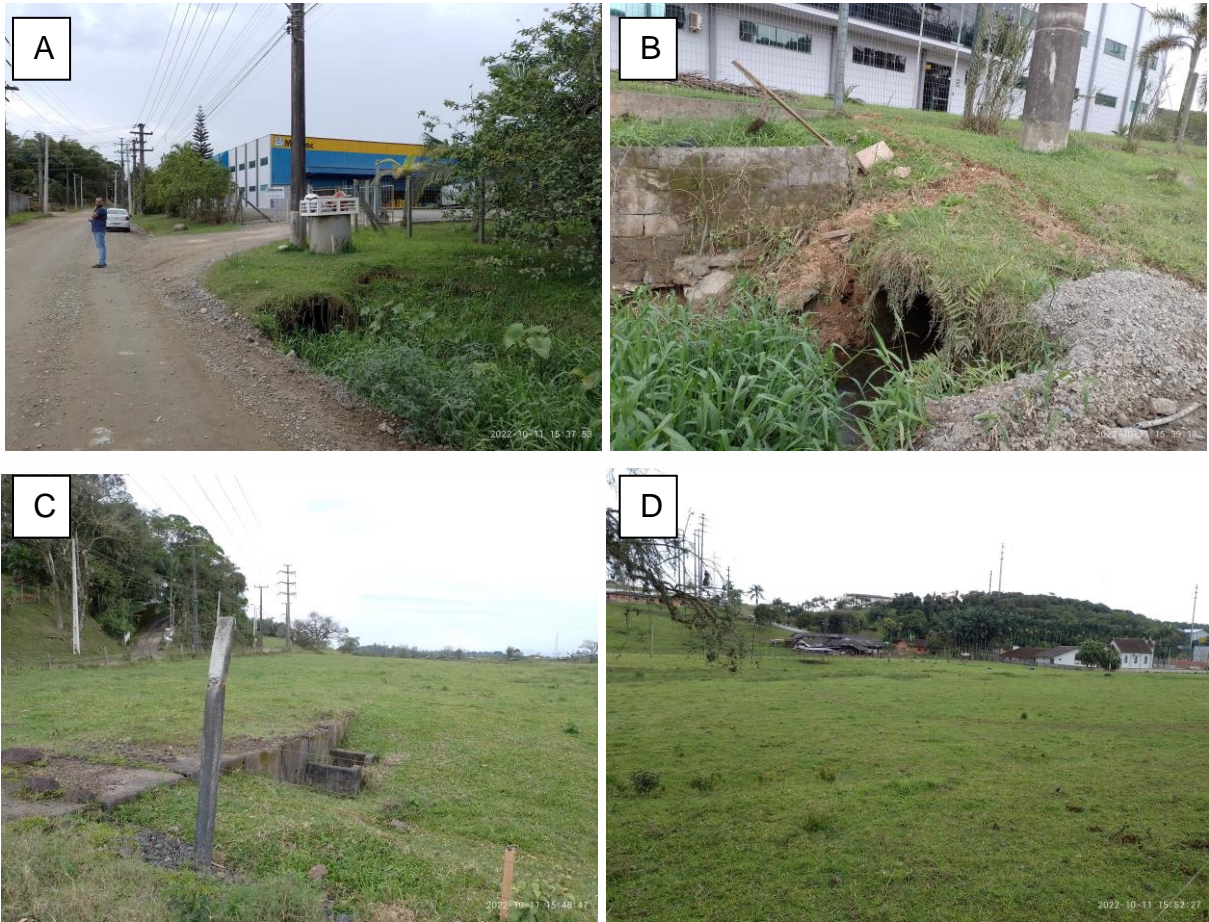
Figura 30: A: Tubulação do trecho 53; B: Trecho 53 para trecho 54 (aberto); C: Início trecho 57 (fechado). D: Contexto do trecho 64 e 65.
