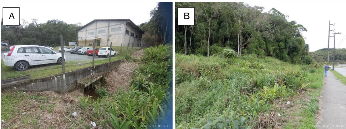
Figura 21: A: Trecho 18 para 19. B: Vista para trecho 19, paralelo a via. Fonte: Autores.
