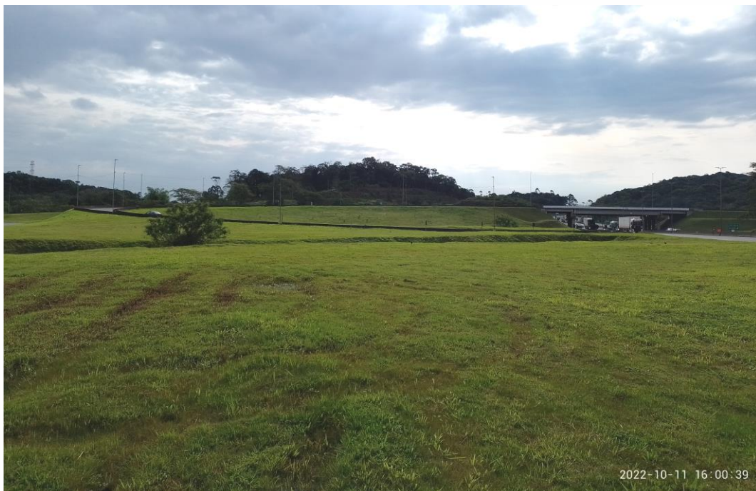
Figura 8: Ambiente da faixa de domínio da rotatória da rodovia federal BR-101 e Eixo Sul – região da foz da MB 30-10.
