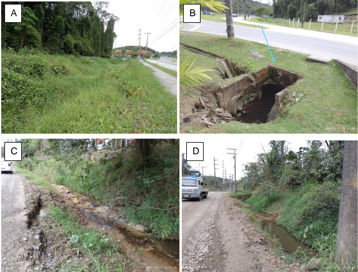
Figura 26: A: Contexto do trecho 40, vista para jusante; B: Trecho 42, com vista para trechos 40 e 41; C: Trecho 43, rua Santa Catarina; D: Trecho 45.
