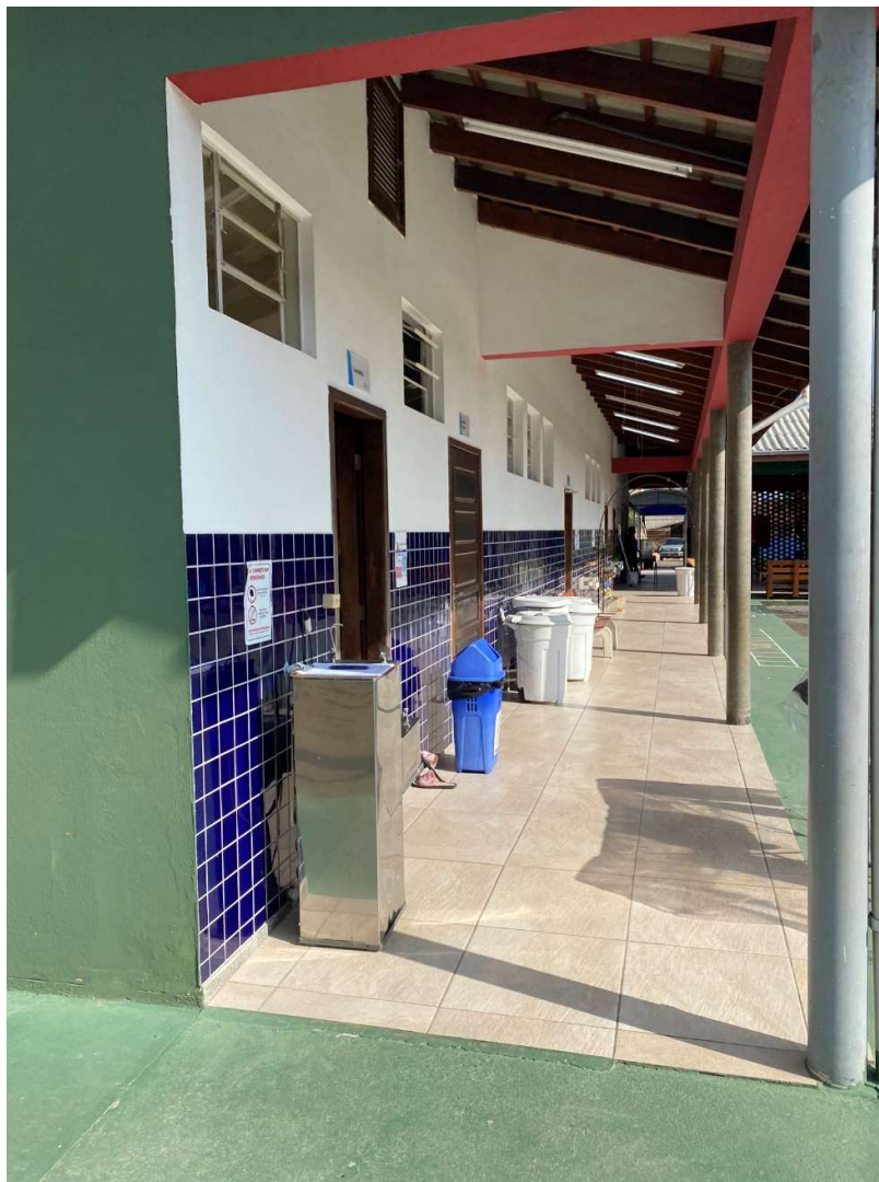
FIGURA 1 - CORREDOR DA ESCOLA COM PARTE DA ESTRUTURA EXISTENTE
