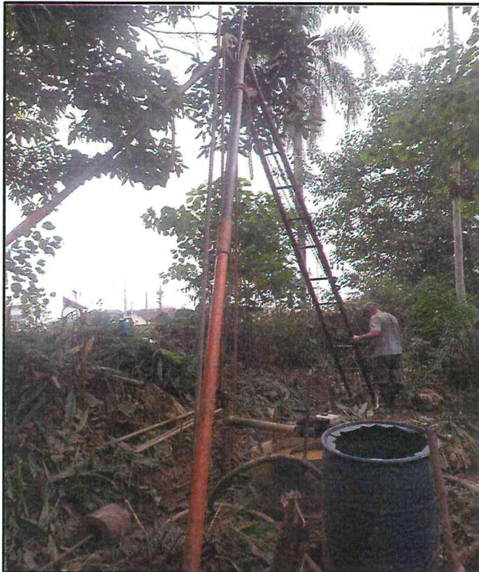
**Figura 02 - Execução do furo de sondagem SPT-02.**
