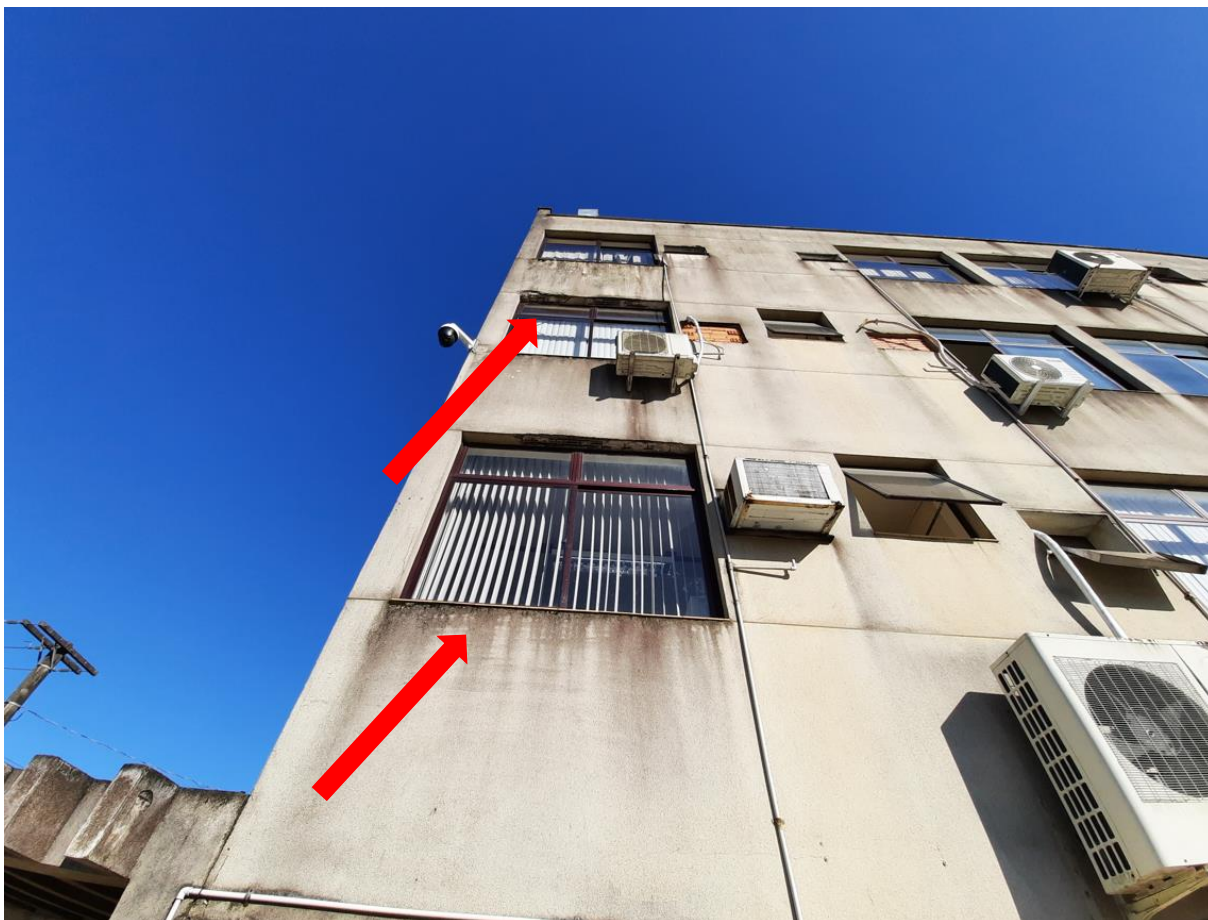
Figura 12: Fachada Leste (lateral)
