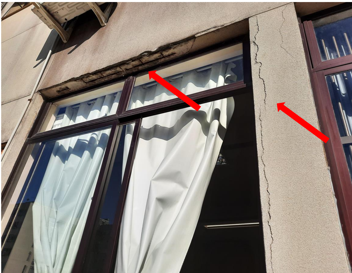
Figura 17: Fachada Leste (lateral)
