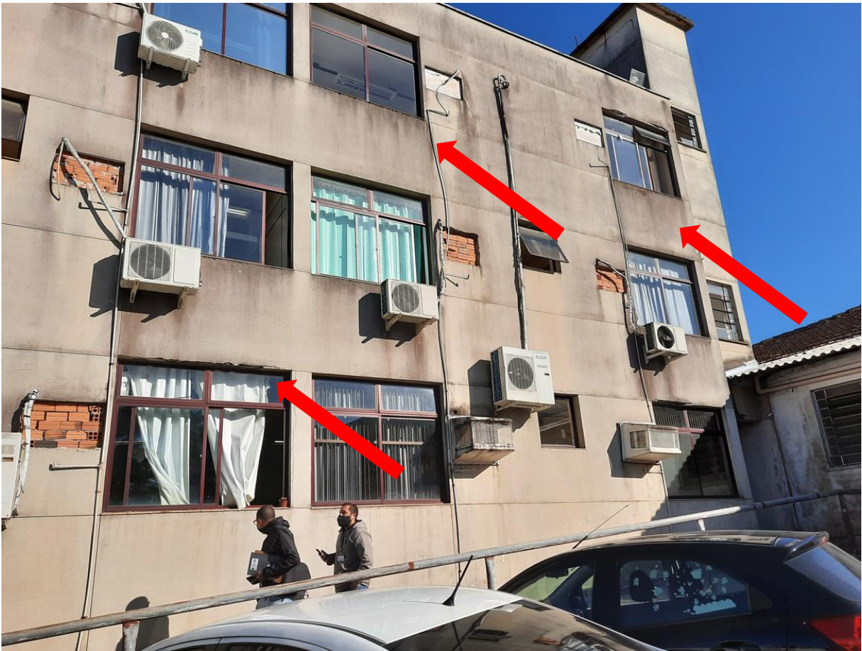
Figura 15: Fachada Leste (lateral)
