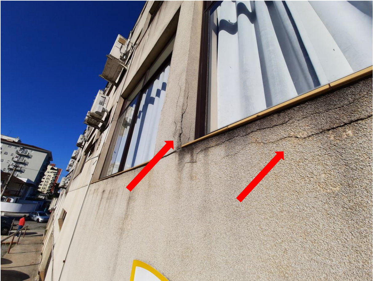
Figura 8: Fachada Leste (lateral)
