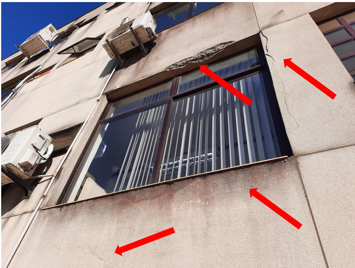
Figura 18: Fachada Leste (lateral)
