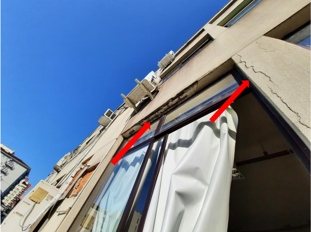
Figura 10: Fachada Leste (lateral)
