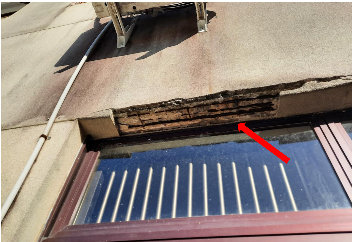
Figura 16: Fachada Leste (lateral)
