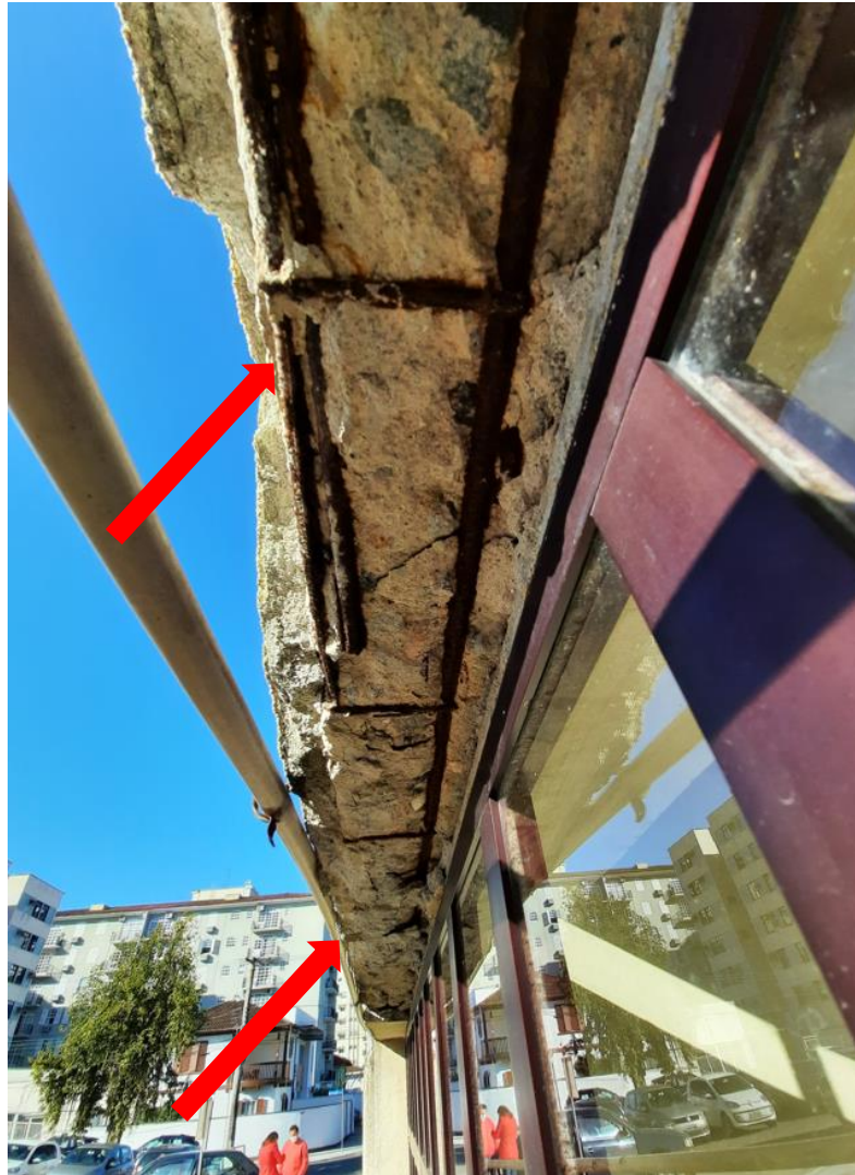
Figura 9: Fachada Leste (lateral)
