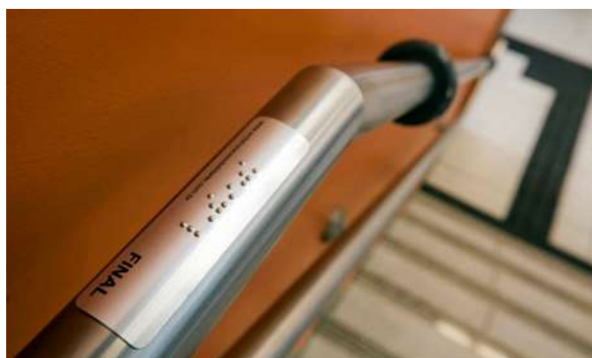
Figura 20 - Exemplo de placa de identificação de pavimento nos corrimãos. Fonte: Internet
