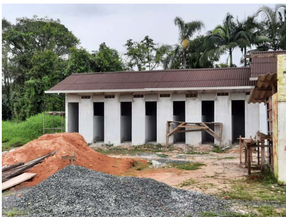
FOTO 08 – Bloco equestre sendo construído.
