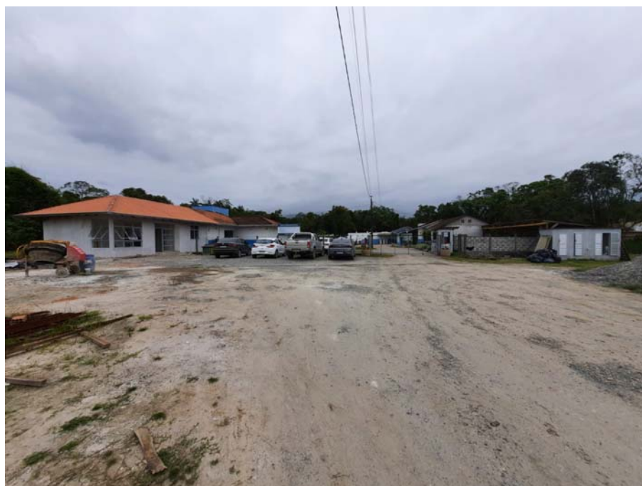
FOTO 02– Vista Geral das edificações
