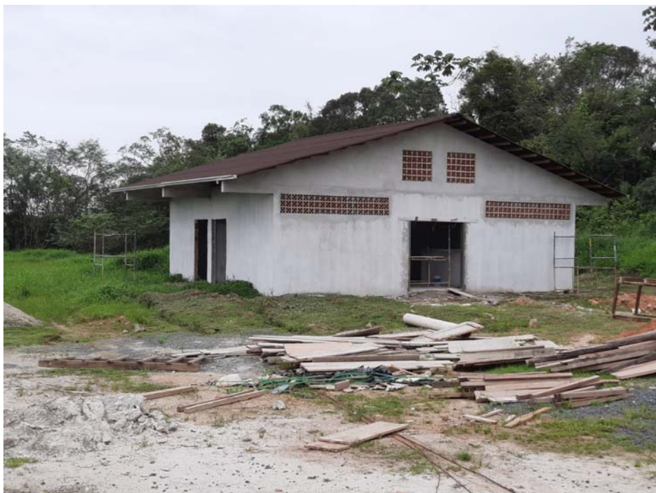
FOTO 07 – Área do canil sendo construída.
