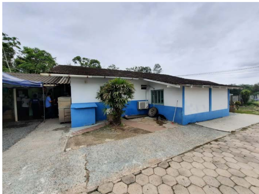
FOTO 04 – Área de serviços
