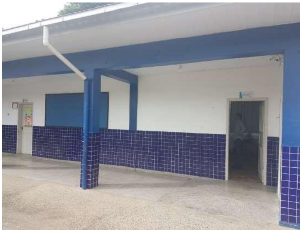
FIGURA 1 - CORREDOR DA ESCOLA COM PARTE DA ESTRUTURA EXISTENTE
