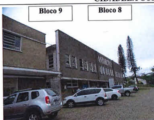
Imagem 53. Vistoria Cidadela Cultural Antarctica (Blocos 8 e 9). Fonte: CPC/SECULT. Data da foto: 17.05.2018.
