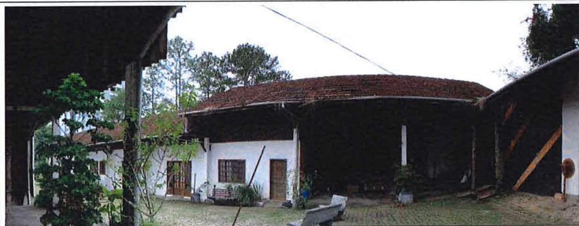
Imagem 47. Vistoria Cidadela Cultural Antarctica (Bloco 12). Fonte: CPC/SECULT. Data da foto: 17.05.2018.
