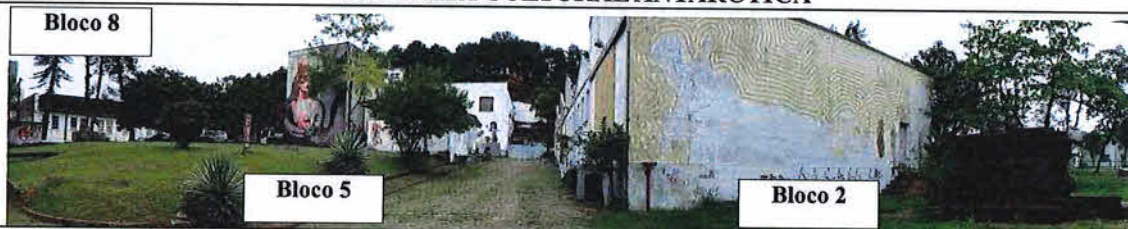
Imagem 29. Vistoria Cidadela Cultural Antarctica (Blocos 2, 5 e 8). Fonte: CPC/SECULT. Data da foto: 17.05.2018.
