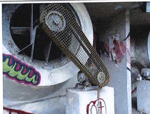
Imagem 20. Vistoria Cidadela Cultural Antarctica (Bloco 5). Fonte: CPC/SECULT. Data da foto: 17.05.2018.
