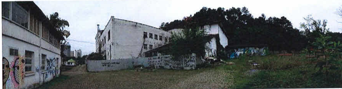
Imagem 02. Vistoria Cidade Cultural Antarctica (Bloco 2 à esquerda e Bloco 10 à direita da foto). Fonte: CPC/SECULT. Data da foto: 17.05.2018.
