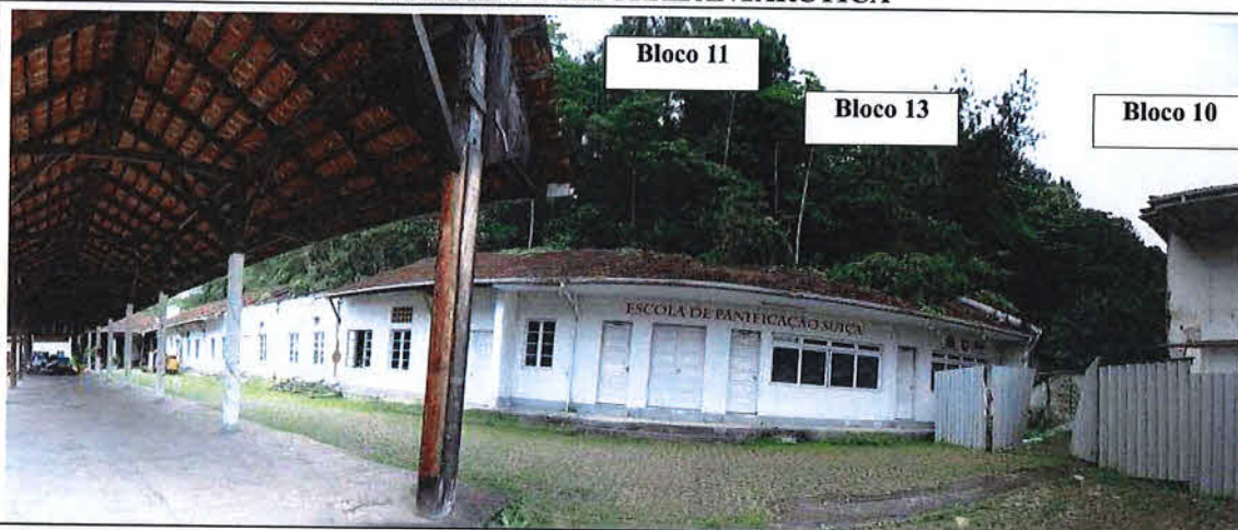
Imagem 39. Vistoria Cidadela Cultural Antarctica (Blocos 10, 11 e 13). Fonte: CPC/SECULT. Data da foto: 17.05.2018.
