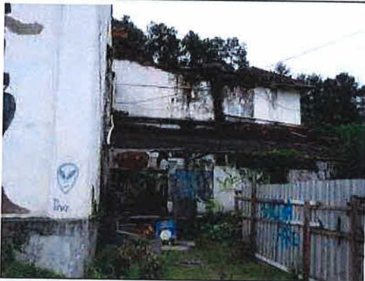
Imagem 09. Vistoria Cidadela Cultural Antarctica (Bloco 10). Fonte: CPC/SECULT. Data da foto: 17.05.2018.
