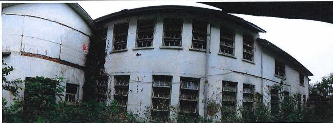
Imagem 42. Vistoria Cidadela Cultural Antarctica (Bloco 10). Fonte: CPC/SECULT. Data da foto: 17.05.2018.
