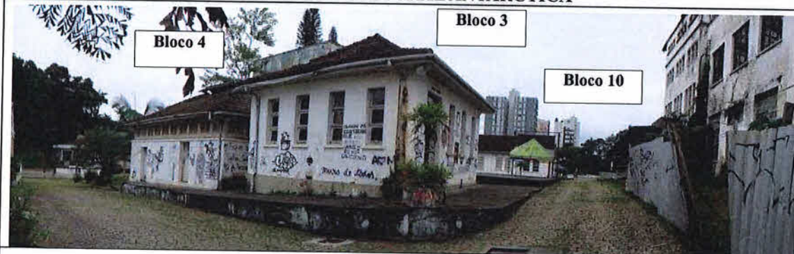
Imagem 06. Vistoria Cidadela Cultural Antarctica (Blocos 3, 4 e 10). Fonte: CPC/SECULT. Data da foto: 17.05.2018.
