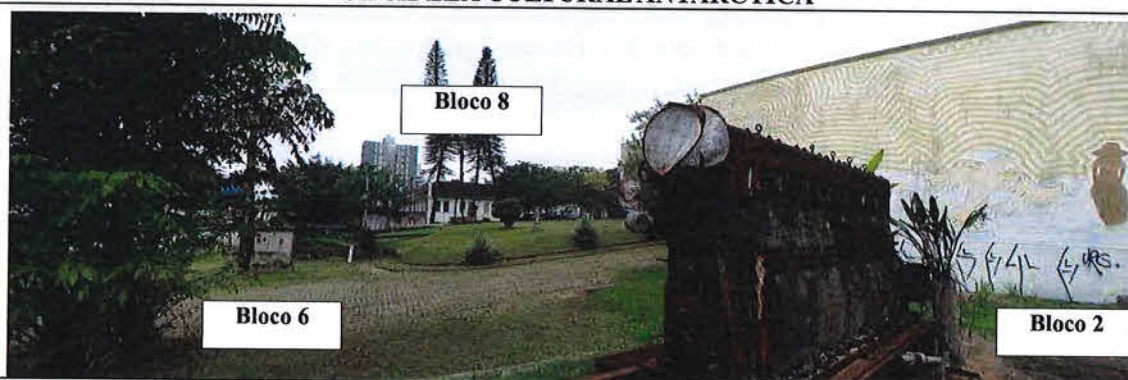
Imagem 30. Vistoria Cidadela Cultural Antarctica (Blocos 2, 6 e 8). Fonte: CPC/SECULT. Data da foto: 17.05.2018.
