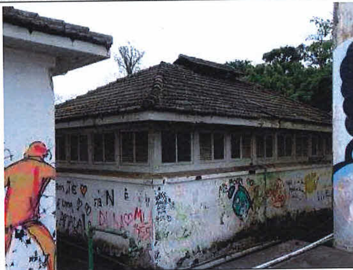
Imagem 13. Vistoria Cidadela Cultural Antarctica (Bloco 4). Fonte: CPC/SECULT. Data da foto: 17.05.2018.
