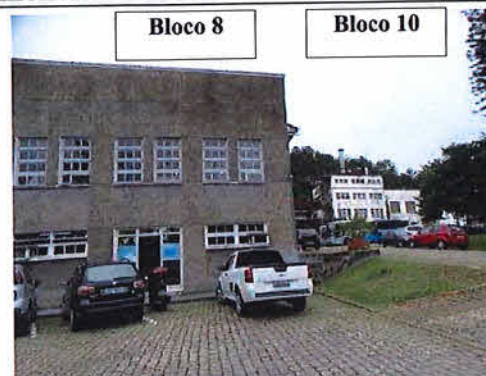
Imagem 54. Vistoria Cidadela Cultural Antarctica (Blocos 8 e 10). Fonte: CPC/SECULT. Data da foto: 17.05.2018.
