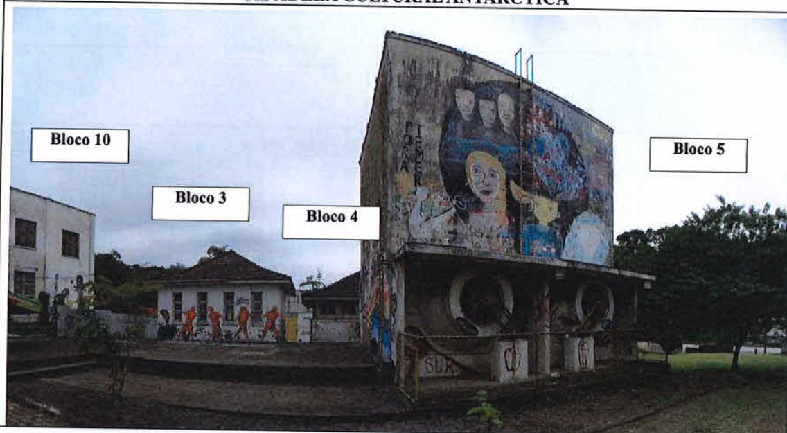
Imagem 18. Vistoria Cidadela Cultural Antarctica (Blocos 3, 4, 5 e 10). Fonte: CPC/SECULT. Data da foto: 17.05.2018.
