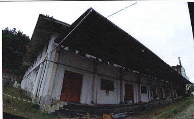
Imagem 35. Vistoria Cidadela Cultural Antarctica (Bloco 10). Fonte: CPC/SECULT. Data da foto: 17.05.2018.
