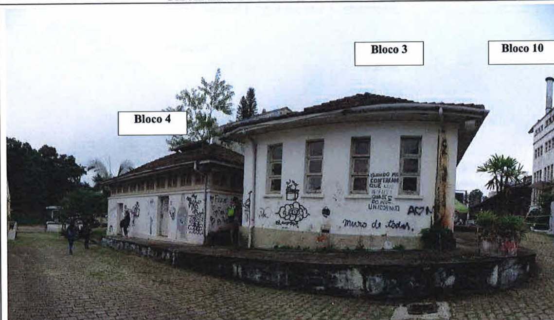
Imagem 31. Vistoria Cidadela Cultural Antarctica (Blocos 3, 4 e 10). Fonte: CPC/SECULT. Data da foto: 17.05.2018.
