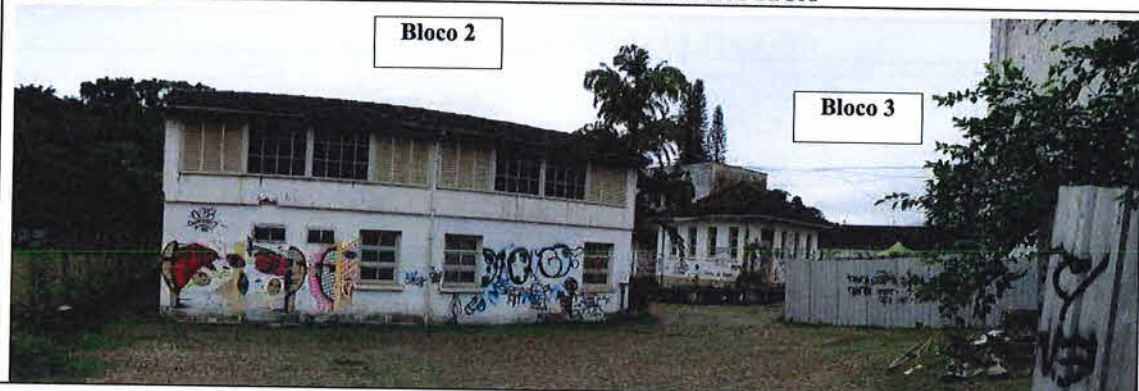
Imagem 04. Vistoria Cidadela Cultural Antarctica (Blocos 2 e 3). Fonte: CPC/SECULT. Data da foto: 17.05.2018.
