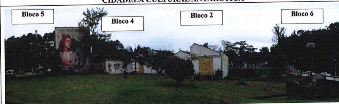
Imagem 22. Vistoria Cidadela Cultural Antarctica (Blocos 2, 4, 5 e 6). Fonte: CPC/SECULT. Data da foto: 17.05.2018.
