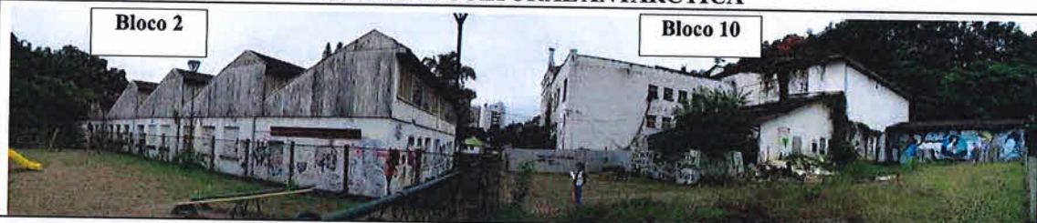
Imagem 05. Vistoria Cidadela Cultural Antarctica (Blocos 2 e 10). Fonte: CPC/SECULT. Data da foto: 17.05.2018.
