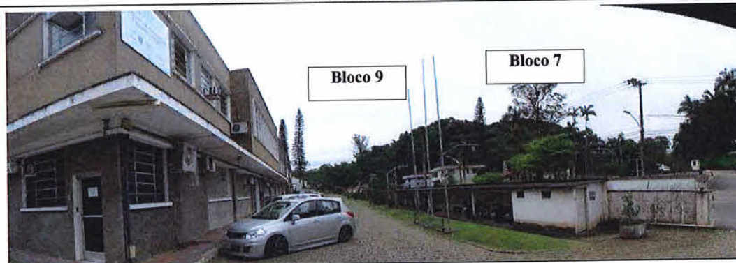
Imagem 52. Vistoria Cidadela Cultural Antarctica (Blocos 7 e 9). Fonte: CPC/SECULT. Data da foto: 17.05.2018.
