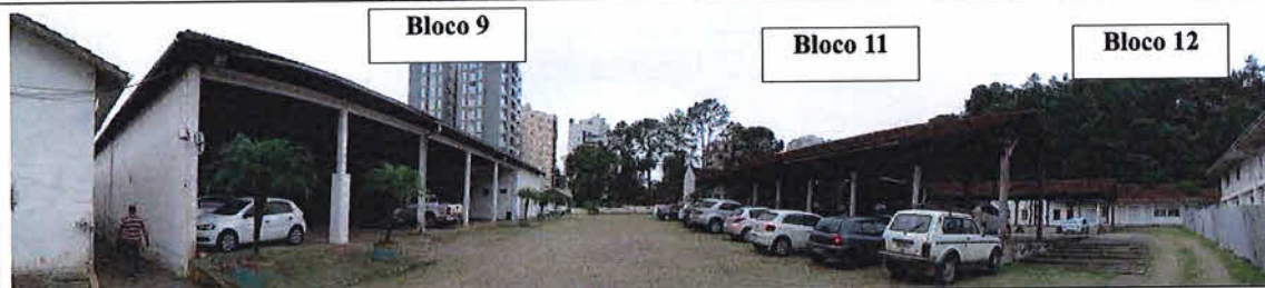
Imagem 37. Vistoria Cidadela Cultural Antarctica (Blocos 9, 11 e 12). Fonte: CPC/SECULT. Data da foto: 17.05.2018.
