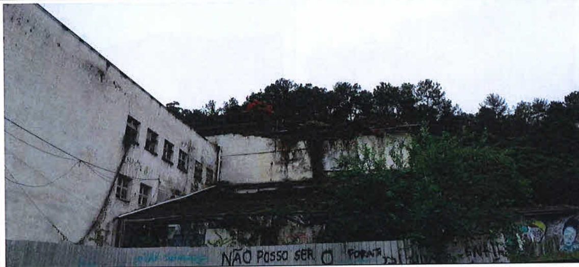
Imagem 07. Vistoria Cidadela Cultural Antarctica (Bloco 10). Fonte: CPC/SECULT. Data da foto: 17.05.2018.
