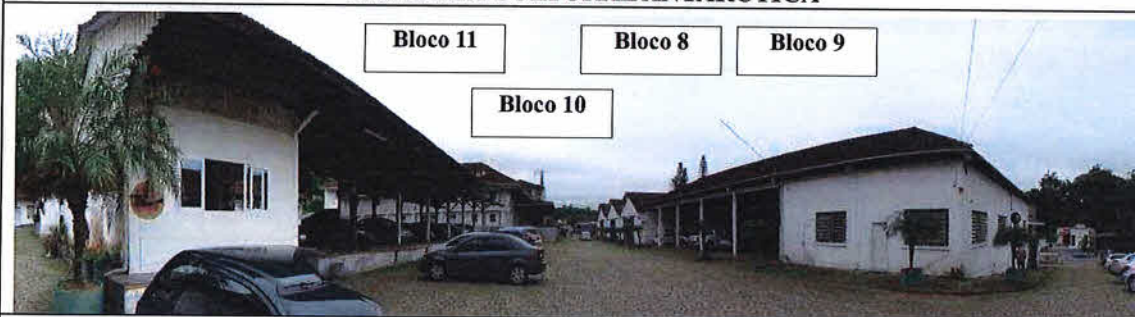
Imagem 49. Vistoria Cidadela Cultural Antarctica (Blocos 8, 9, 10 e 11). Fonte: CPC/SECULT. Data da foto: 17.05.2018.
