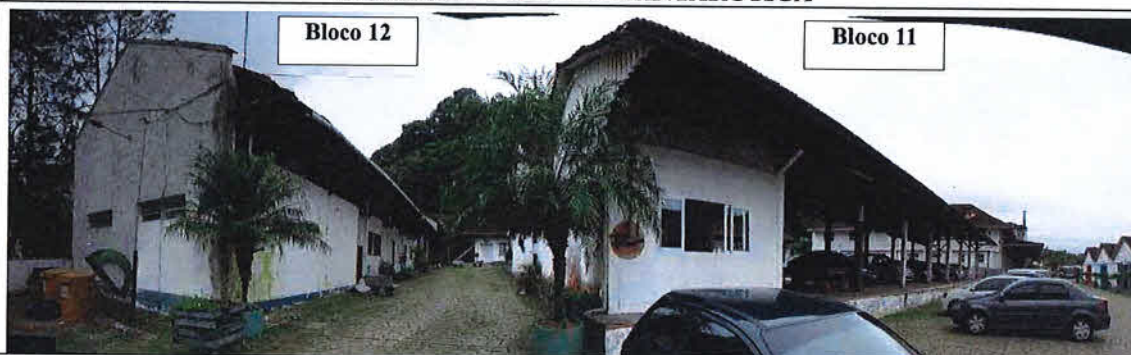
Imagem 48. Vistoria Cidadela Cultural Antarctica (Blocos 11 e 12). Fonte: CPC/SECULT. Data da foto: 17.05.2018.
