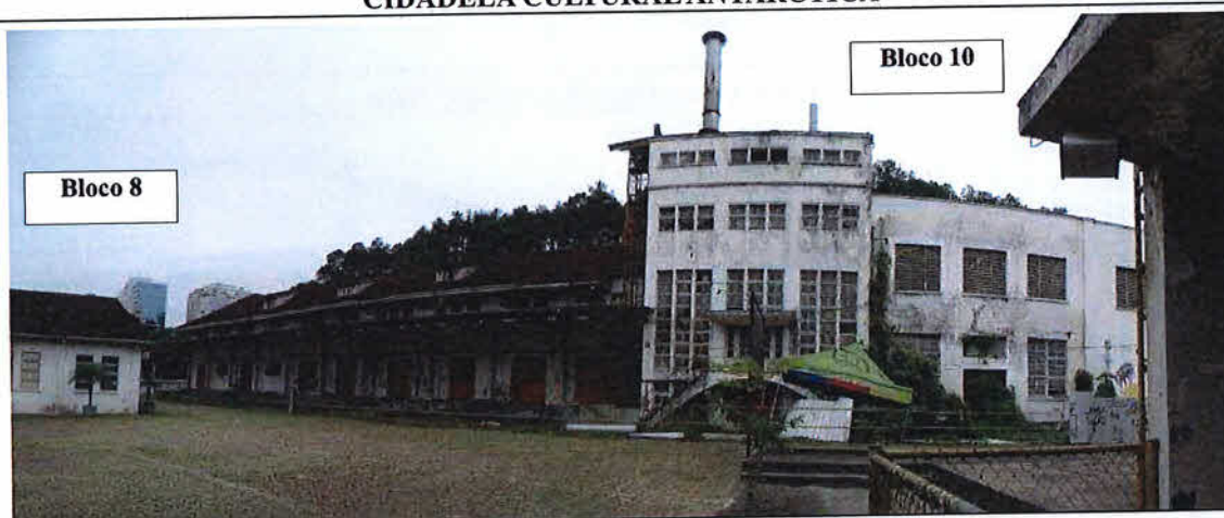
Imagem 21. Vistoria Cidadela Cultural Antarctica (Blocos 8 e 10). Fonte: CPC/SECULT. Data da foto: 17.05.2018.
