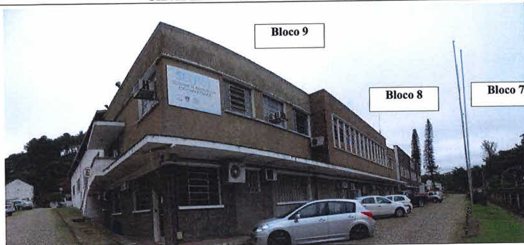
Imagem 51. Vistoria Cidadela Cultural Antarctica (Blocos 7, 8 e 9). Fonte: CPC/SECULT. Data da foto: 17.05.2018.
