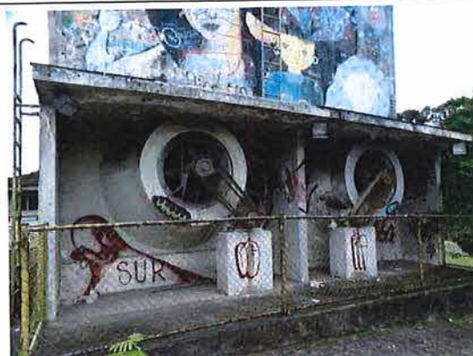
Imagem 19. Vistoria Cidadela Cultural Antarctica (Bloco 5). Fonte: CPC/SECULT. Data da foto: 17.05.2018.
