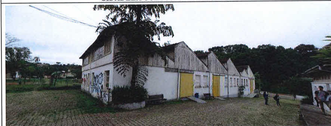
Imagem 32. Vistoria Cidadela Cultural Antarctica (Bloco 2). Fonte: CPC/SECULT. Data da foto: 17.05.2018.
