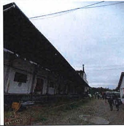
Imagem 36. Vistoria Cidadela Cultural Antarctica (Bloco 10). Fonte: CPC/SECULT. Data da foto: 17.05.2018.
