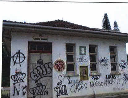
Imagem 10. Vistoria Cidadela Cultural Antarctica (Bloco 3). Fonte: CPC/SECULT. Data da foto: 17.05.2018.
