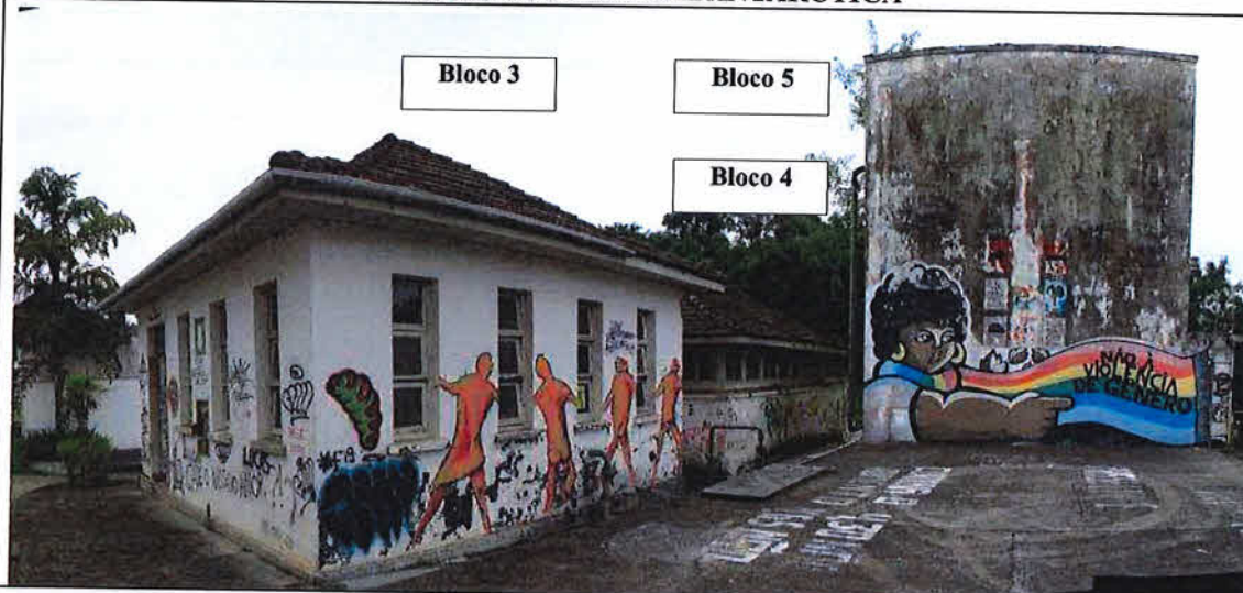
Imagem 11. Vistoria Cidadela Cultural Antarctica (Blocos 3, 4 e 5). Fonte: CPC/SECULT. Data da foto: 17.05.2018.
