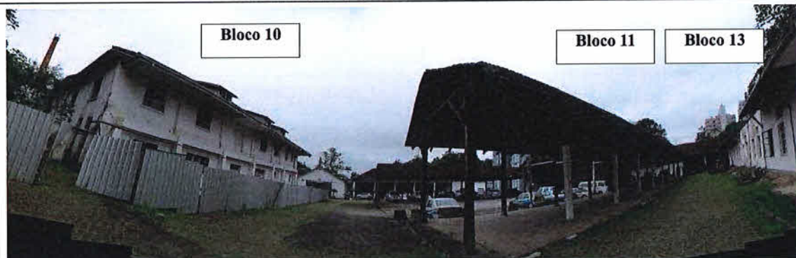
Imagem 43. Vistoria Cidadela Cultural Antarctica (Blocos 10, 11 e 13). Fonte: CPC/SECULT. Data da foto: 17.05.2018.
