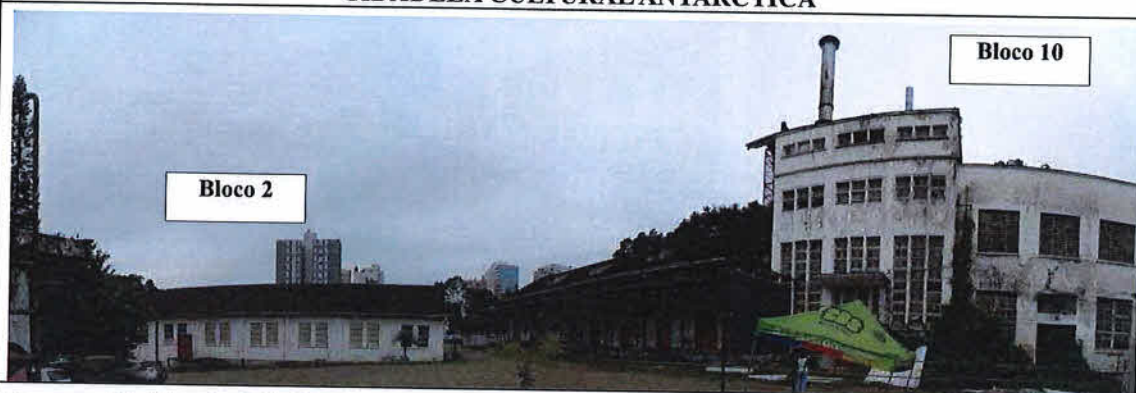
Imagem 17. Vistoria Cidadela Cultural Antarctica (Blocos 2 e 10). Fonte: CPC/SECULT. Data da foto: 17.05.2018.
