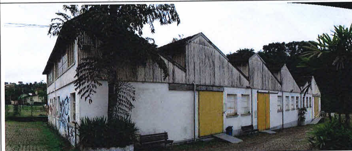
Imagem 08. Vistoria Cidadela Cultural Antarctica (Bloco 2). Fonte: CPC/SECULT. Data da foto: 17.05.2018.
