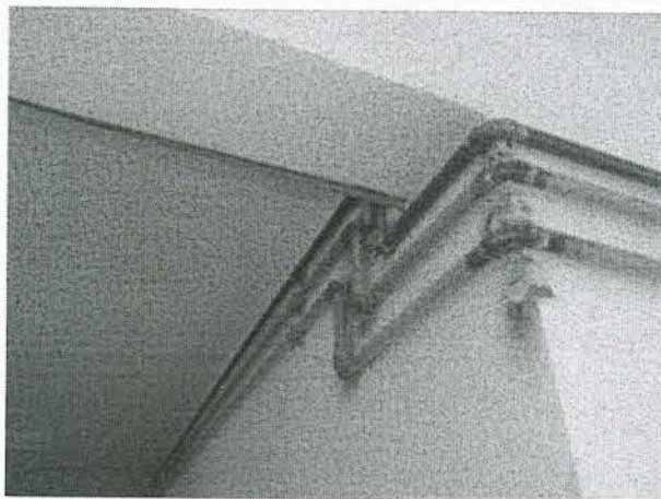
Figura 8 – União das conexões soldáveis pelo processo de brasagem capilar.
