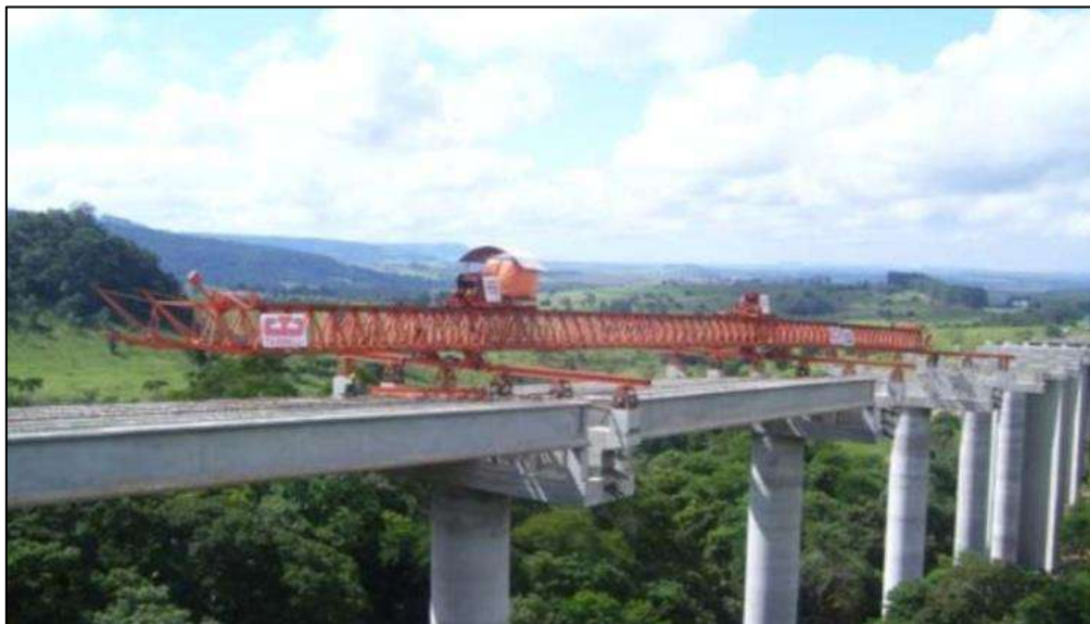
Figura 4 - DETALHE TRELIÇA LANÇADEIRA
