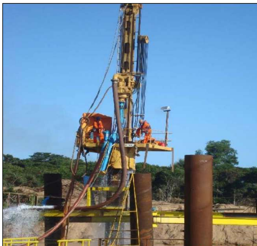
Figura 12 - DETALHE CRAVAÇÃO DA CAMISA
