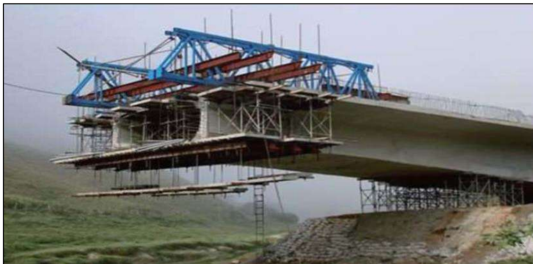
Figura 6 - FOTO EXECUÇÃO DE BALANÇO SUCESSIVO
