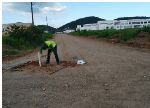
Execução da Sondagem
