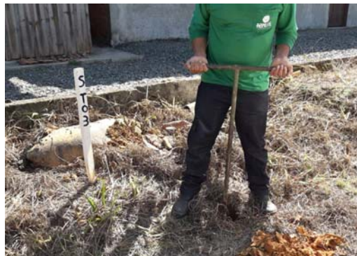
Execução da Sondagem
