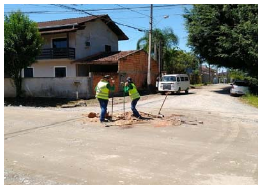
Execução da Sondagem
