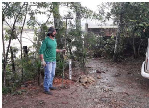
Execução da Sondagem
