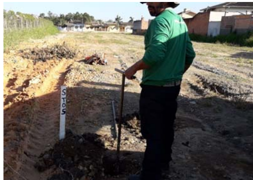
Execução da Sondagem
