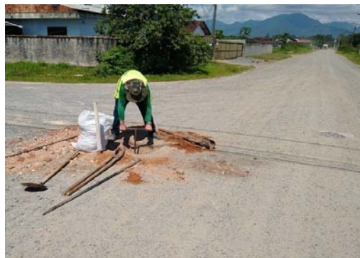
Execução da Sondagem
