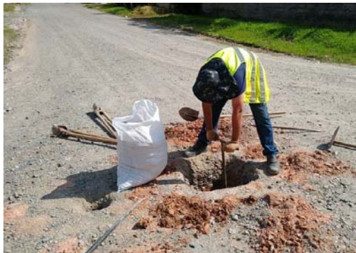
Execução da Sondagem
