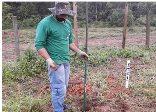
Execução da Sondagem
