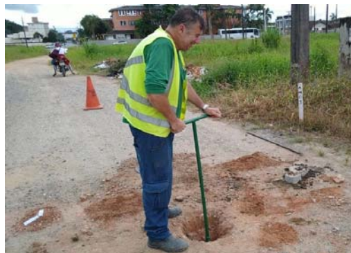
Execução da Sondagem
