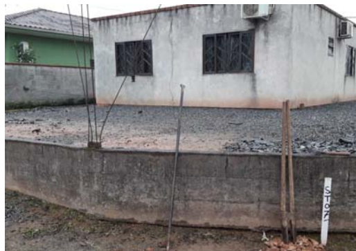
Execução da Sondagem
