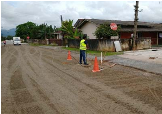
Execução da Sondagem
