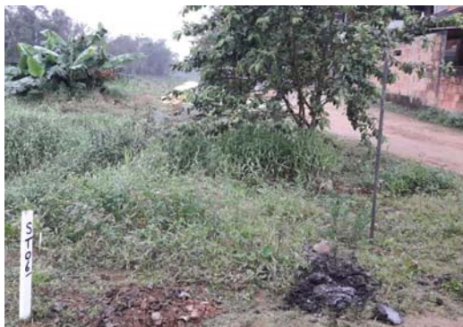
Execução da Sondagem
