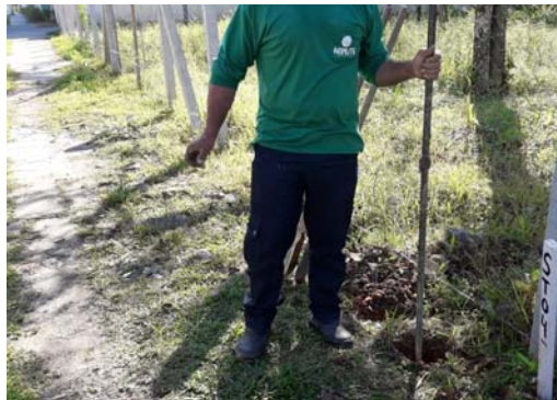
Execução da Sondagem
