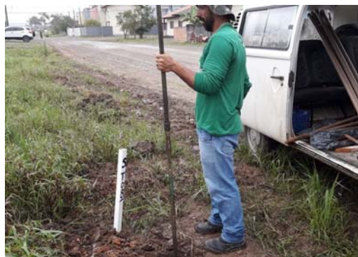
Execução da Sondagem
