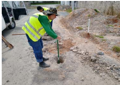
Execução da Sondagem
