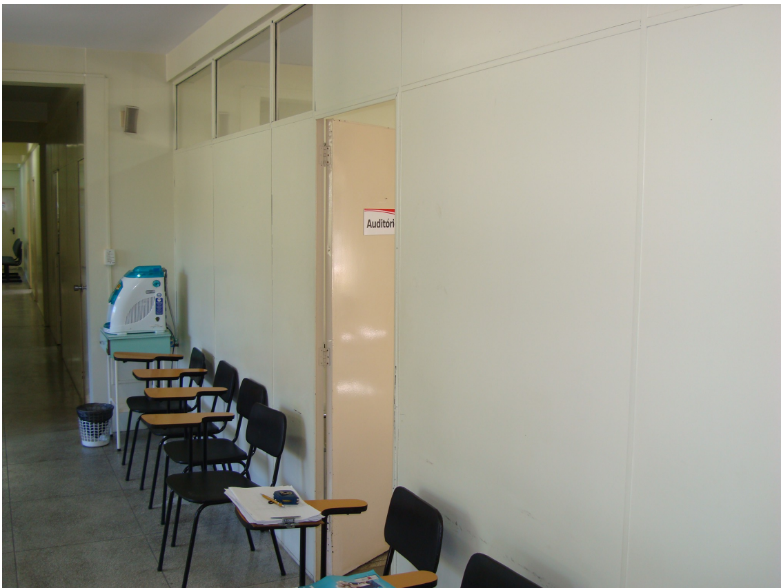
Foto 12: Sala de reuniões (pavto. superior) remoção de divisória; fechamento em blocos concreto celular e troca de piso interno.
