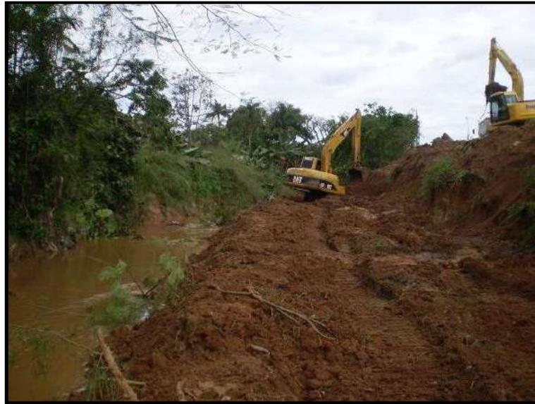
Figura 8.1 - Duas Operações “tombos” primeira escavadeira alargando e escavando área da seção molhada e a segunda posicionada em cima para carregar o caminhão.
