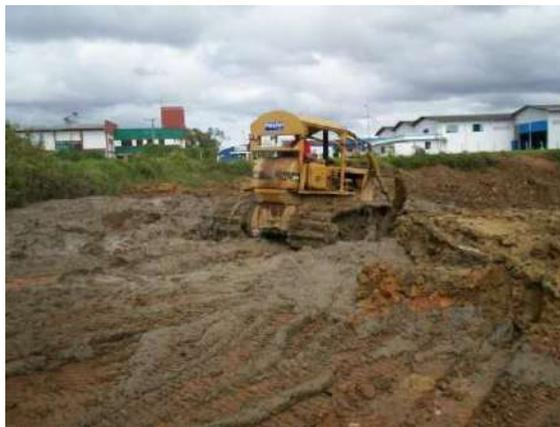
Figura 8.3 - Trator de esteira com lamina espalhando bota fora, geralmente material úmido e no momento com baixo suporte.
