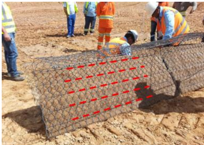
Figura 14.5 - Varetas de reforço destacadas em vermelho.
