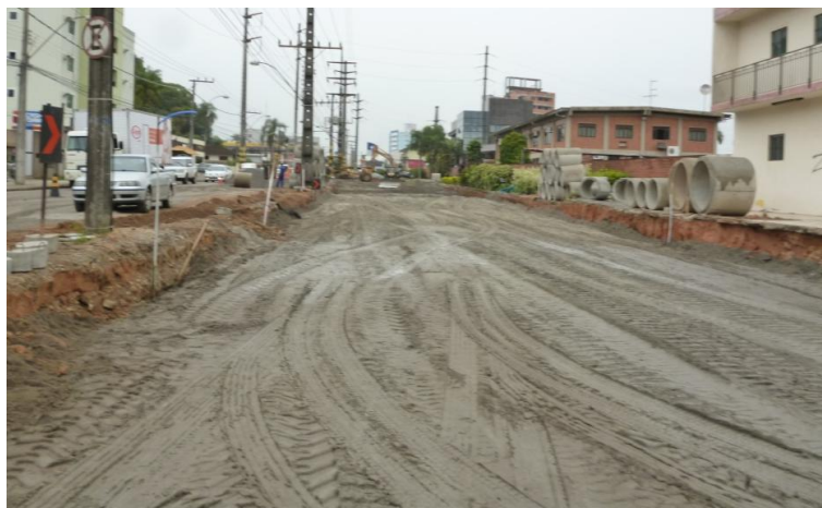
Figura 12.1 - Execução do reforço com areia, trecho entre a Rua Dom Bosco e Palmitos. Fonte: Azimute, dezembro de 2013.
