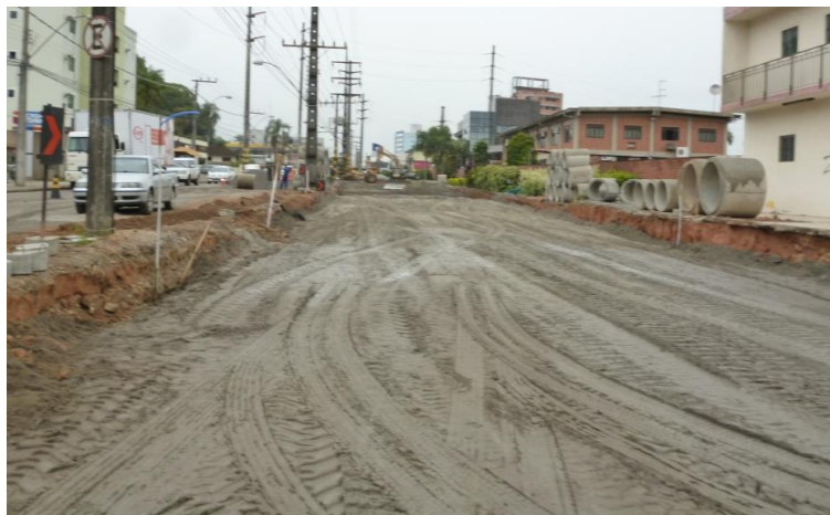
Figura 6.16 - Execução do reforço com areia, trecho entre a Rua Dom Bosco e Palmitos. Fonte: Azimute, Dezembro de 2013.
