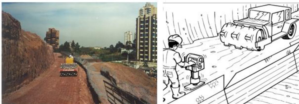
Figura 18.6 - Compactação do aterro respeitando a distância mínima de 1,00 do paramento frontal para equipamentos pesados.
