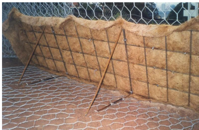
Figura 14.6 - Malha eletrossoldada e triângulos de aço devidamente posicionados.
