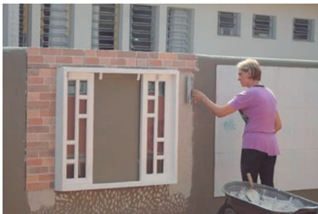
Figura 3 – Construção da janela
