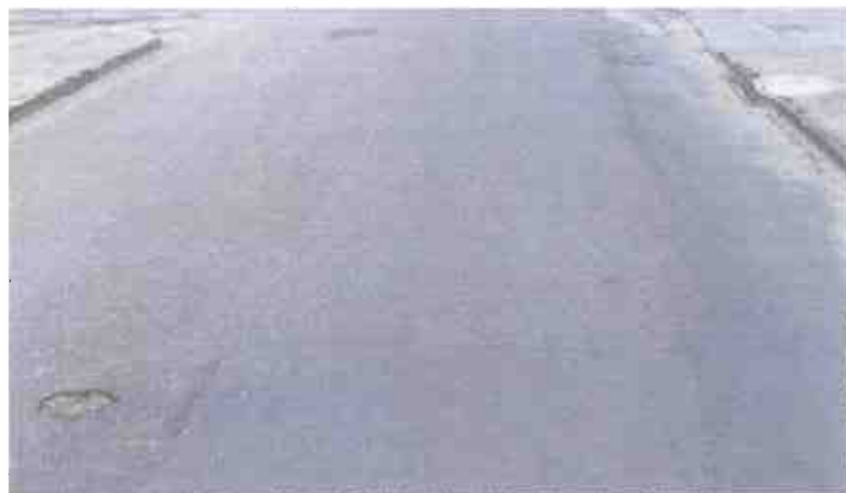
Foto 15: Remendo, Trincas Classe 2 (FC2) e Panela .
