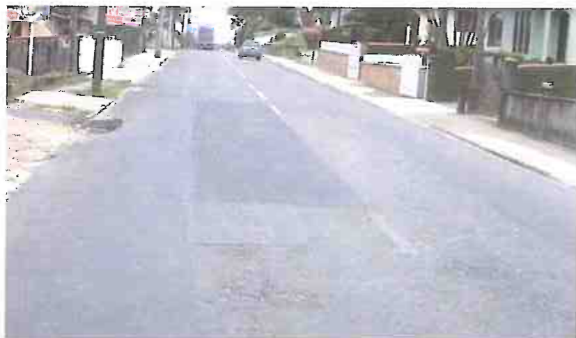
Foto 13: Remendo, Trincas Classe 2 e 3 (FC2 e FC3) e Desgaste
