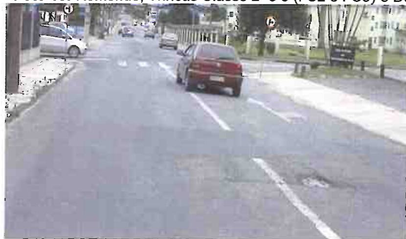
Foto 14: Remendo, Trincas Classe 3 (FC3) e Panela
