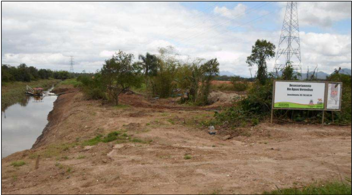
Foto 4.7 - Trecho licenciado – travessia com a Rua Minas Gerais.
