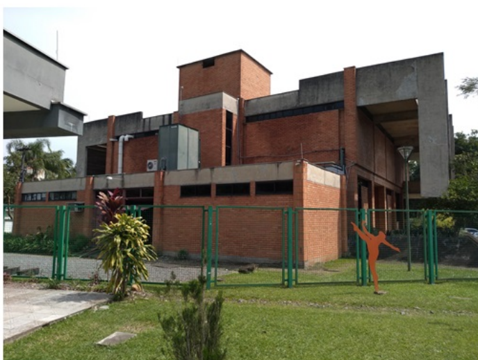
Imagem 03: Edificação construída para receber o acervo do Arquivo Histórico de Joinville. Vista dos fundos a partir do terreno da Casa da Cultura. (Data: Setembro/2018) Fonte: Seinfra – BP
