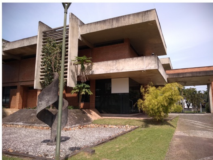
Imagem 02: Edificação construída para receber o acervo do AHJ. Vista lateral esquerda. (Data: Setembro/2018) Fonte: Seinfra – BP
