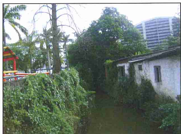
Figura 29 – Construção sob o leito do rio Mathias – próximo a rua Albano Schultz.
