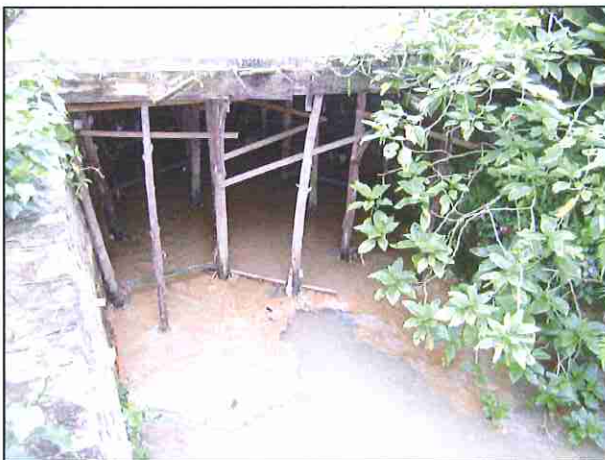
Figura 28 – Obstrução da ponte da rua Aquidaban – rio Mathias.
