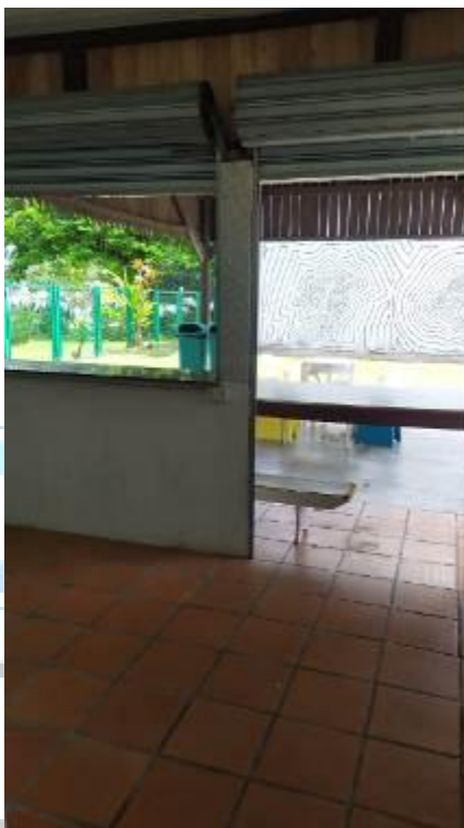
FOTO 5: Interior do imóvel
