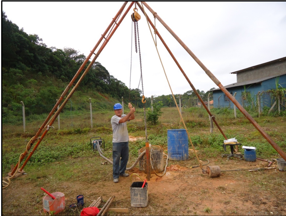
Figura 05 - Execução do furo de sondagem SPT-02
