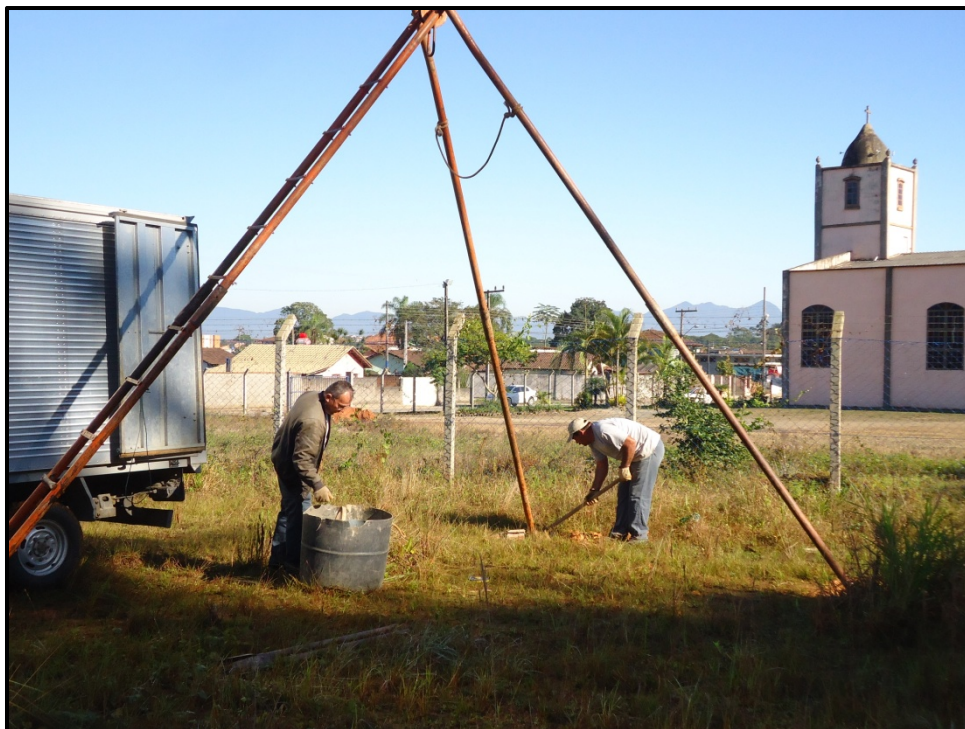
Figura 03 - Execução do furo de sondagem SPT-01.
