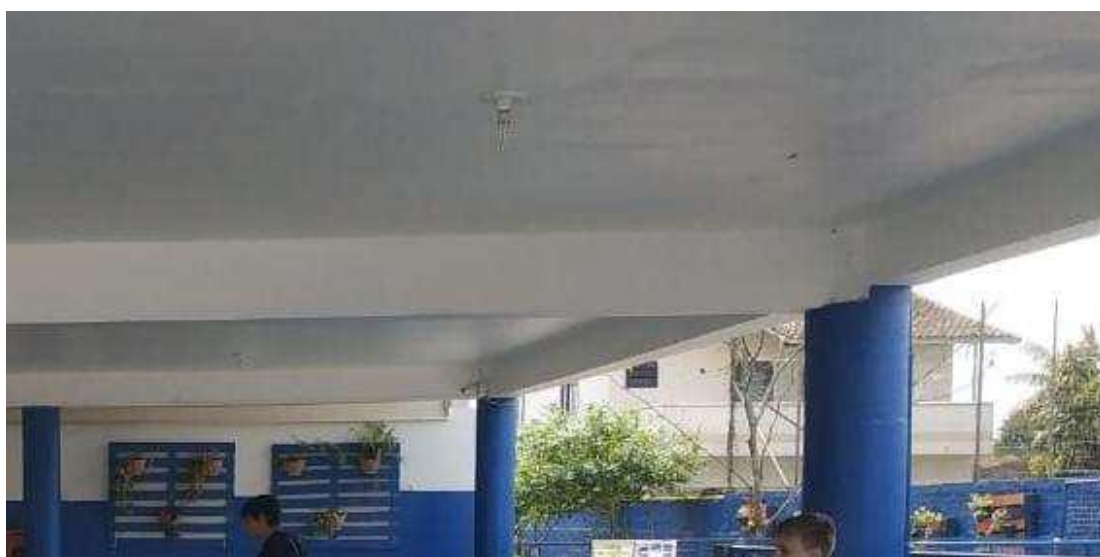
FIGURA 1 - CORREDOR DA ESCOLA COM PARTE DA ESTRUTURA EXISTENTE
