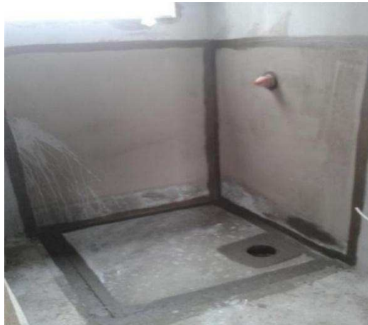
Impermeabilização de superfície, com impermeabilizante flexível a base acrílica.
