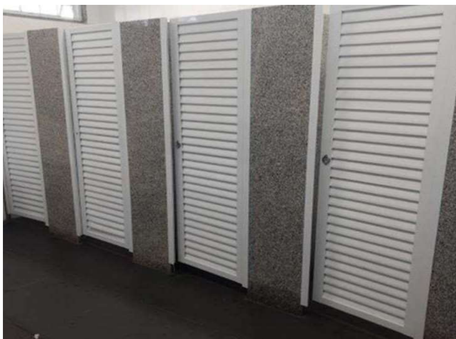
DIVISÓRIAS SANITÁRIOS DIVISÓRIA DE GRANITO CINZA ANDORINHA PORTAS COM VENEZIANA VENTILADA
