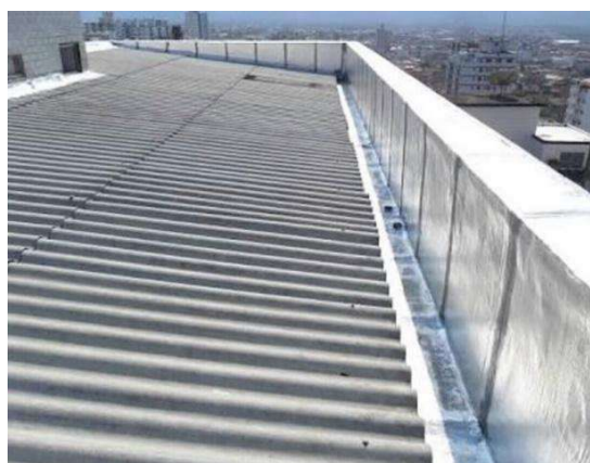
CALHA DE CONCRETO IMPERMEABILIZADA COM MANTA ASFÁLTICA.
