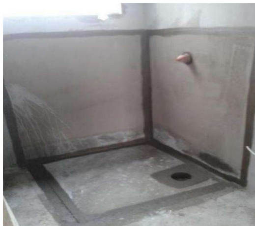
IMPERMEABILIZACAO DE SUPERFICIE, COM ARGAMASSA COM ADITIVO IMPERMEABILIZANTE.
