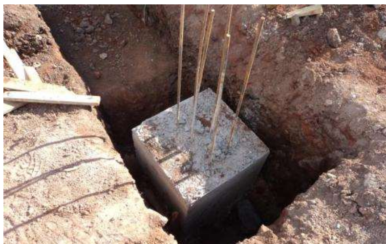
BLOCOS DE FUNDAÇÃO CONVENCIONAL
