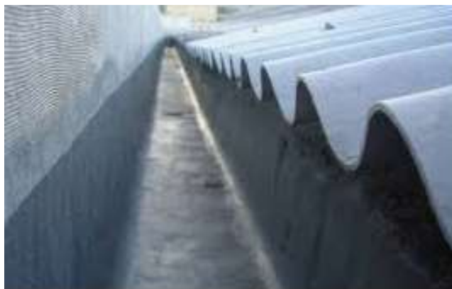
CALHA DE ALVENARIA IMPERMEABILIZADA COM MANTA ASFÁLTICA
