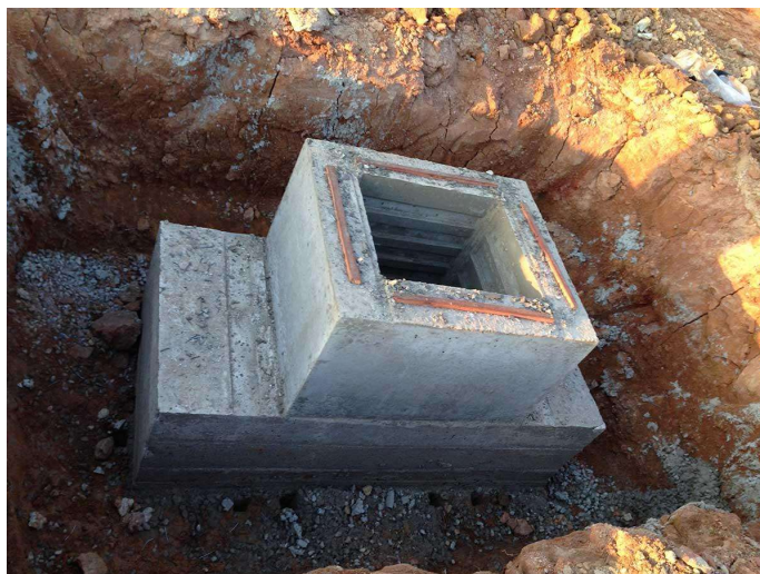
BLOCO DE FUNDAÇÃO COM CÁLICE PARA PILARES PRÉ-MOLDADOS
