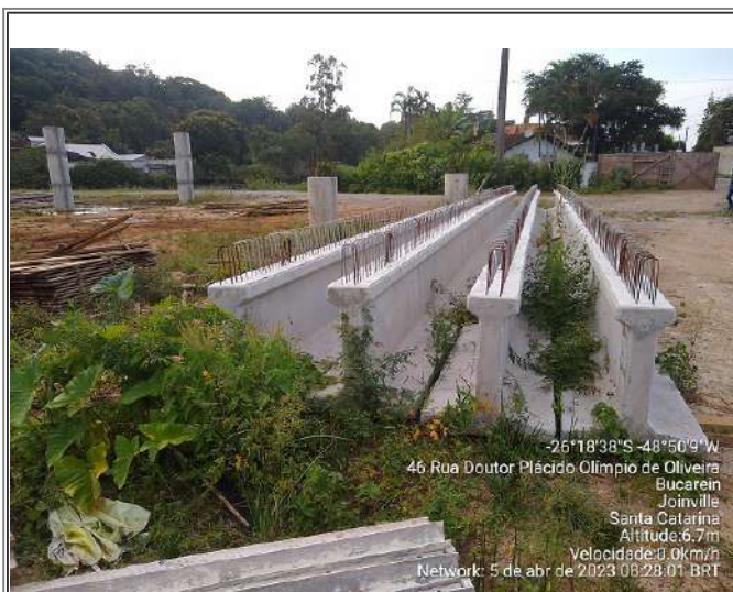
Vigas Pré-Moldadas
