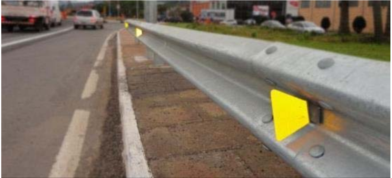
Figura 4.15 - Refletivos para defesa metálica.
