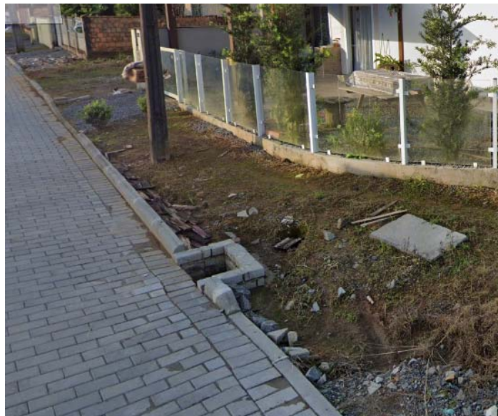
Figura 3.4 – Ilustração de Boca de Lobo a remover para execução dos SuDS
