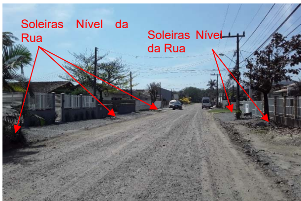
Figura 1.1 - Rua Alex Kricheldorf– Segmento com identificação das soleiras dos portões em relação ao nível da pista existente. Fonte: Azimute, 2020.
