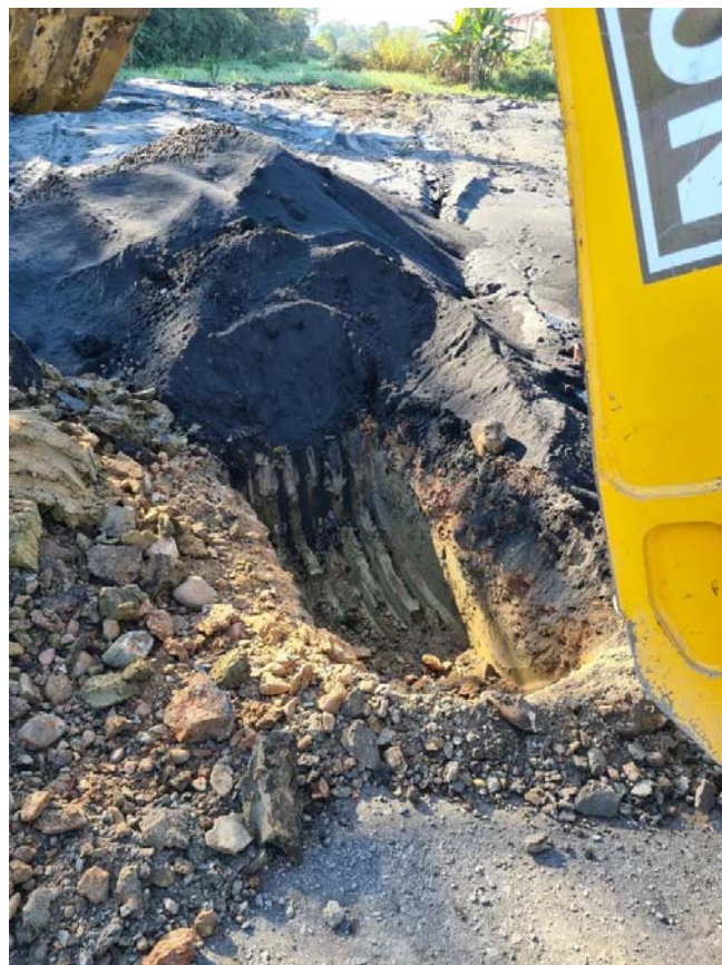
Figura 5.12 – Inspeção Campo. Fonte: SAP.UCP - PMJ, 2021.
