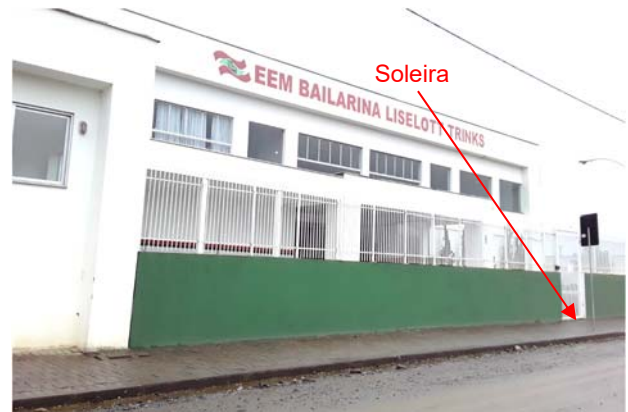
Figura 1.6 - Rua Rudolf Baumer - Cota existente da pista já compatível com o nível da edificação.
