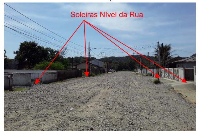
Figura 1.4 - Rua São Virgílio - Soleiras dos portões no nível da pista existente. Fonte: Azimute, 2020.
