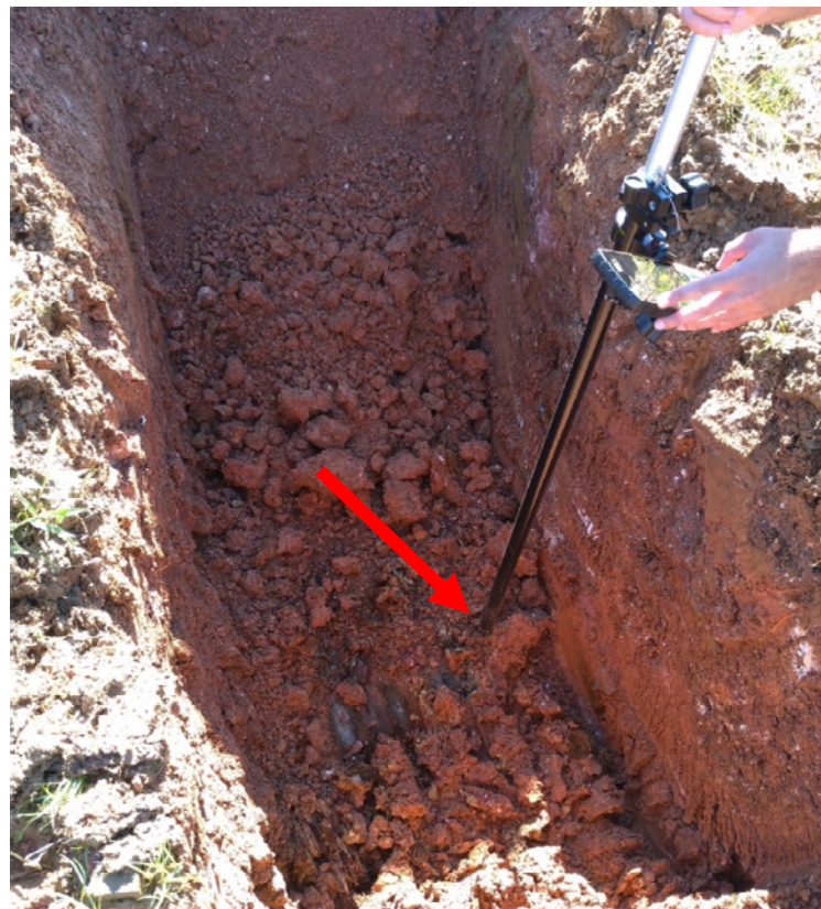
Figura 5.10 - Rua Laércio Beninca – Rede identificada.
