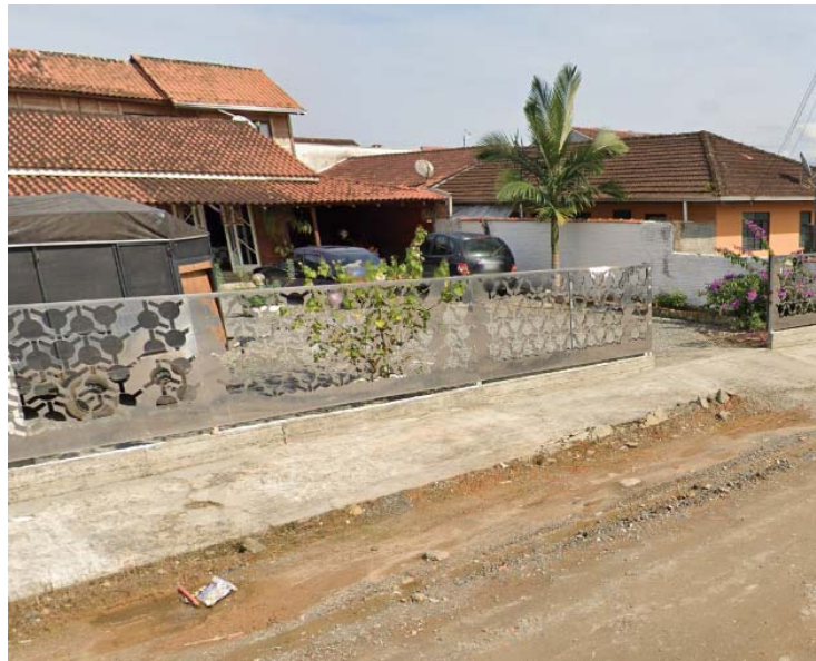
Figura 3.3 – Ilustração de passeio a remover para execução dos SuDS
