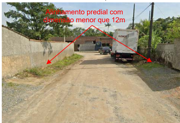
Figura 1.3 - Rua Comandante Karl Busch – Trecho com alinhamento predial existente impactando na largura da via projetada. Fonte: Azimute, 2020.
