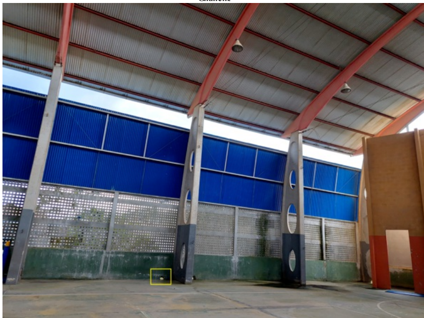
Figura 10 - Indicação, em amarelo, de um dos furos existentes nas paredes de fechamento da Quadra Coberta E.M. Sadalla Amin Ghanem.
