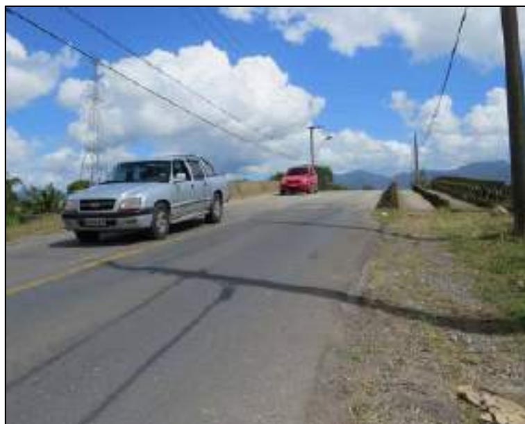
Figura 2.34 - Infraestrutura viária – Ponte Rua Minas Gerais.
