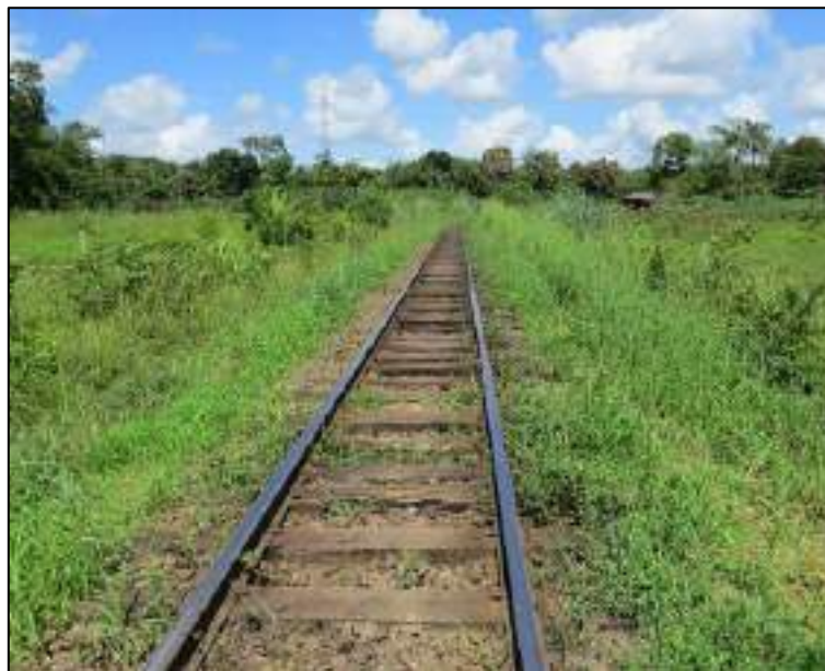
Figura 2.38 - Ferrovia em APP.
