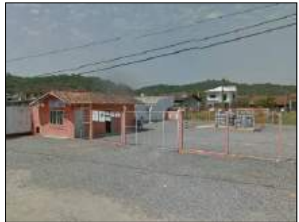
Figura 2.54 - Distribuidora de gás.
