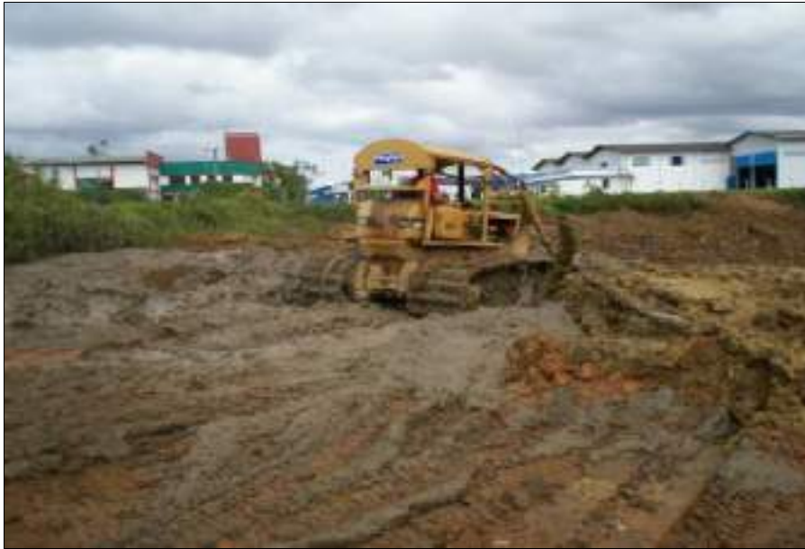
Figura 2.25 - Trator de esteira operando no bota-fora.
