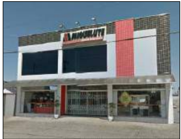
Figura 2.60 - Loja de material de construção.
