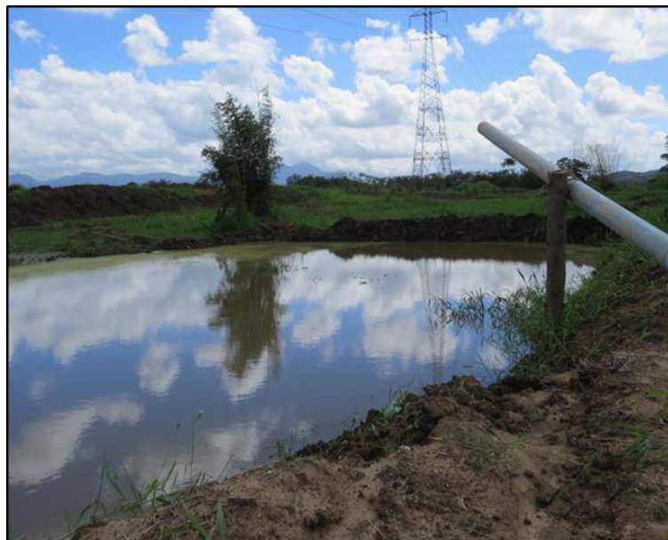
Figura 2.22 - Captação de água áreas de esgotamento para uso na irrigação.
