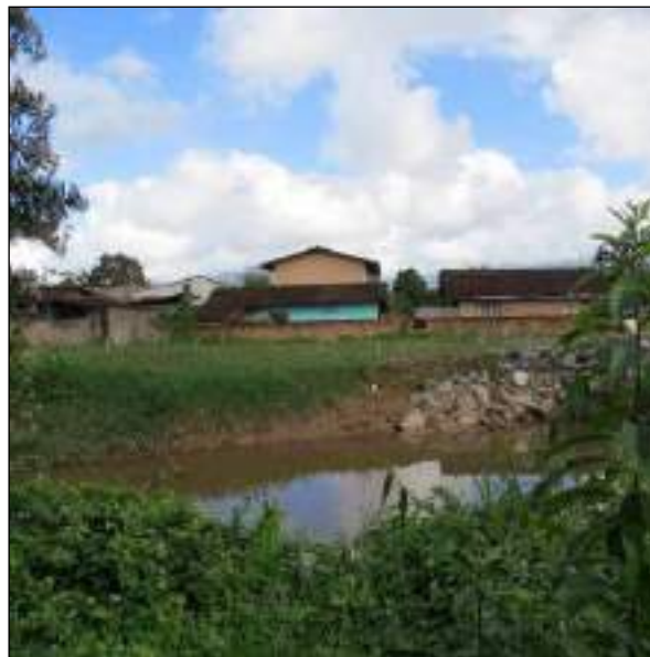
Figura 2.70 - Vista o trecho onde a ocupação residencial ocorre bem próximo do canal a ser dragado, inclusive sobre a faixa integrada pela ADA do projeto.
