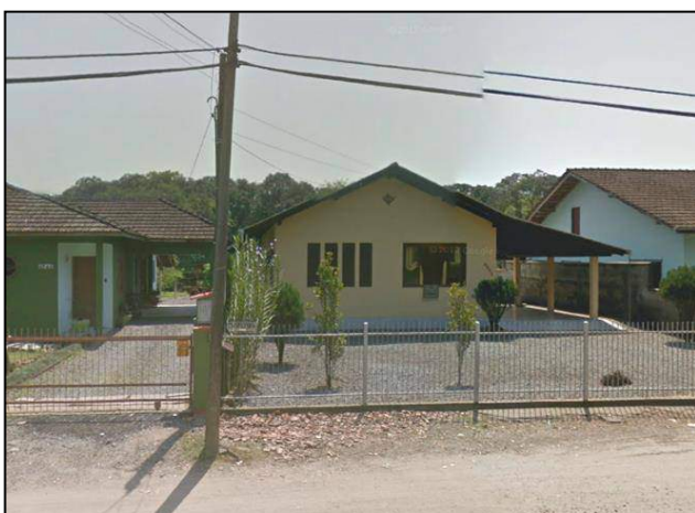
Figura 2.52 - Tomada parcial de residências na Rua Minas Gerais.
