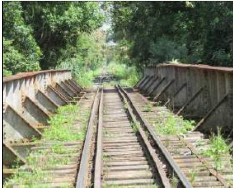
Figura 2.39 - Infraestrutura para ferrovia - Ponte em estrutura metálica sobre o rio.
