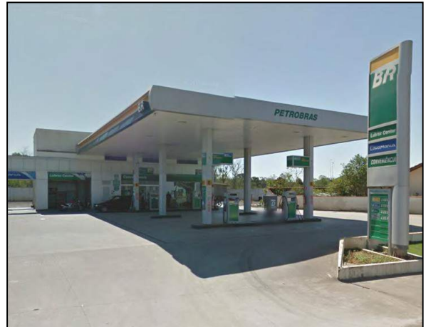
Figura 2.59 - Posto de gasolina.
