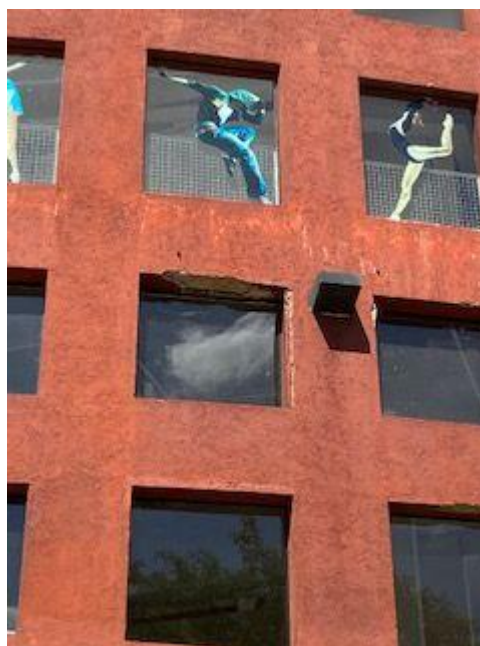
Reparos no reboco da fachada frontal, inclusive nas bordas das aberturas (doc. SEI nº 0014997391).
