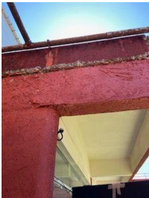
Aplicação de graute, cimento C3 e tela de aço (figura 05 do memorial descritivo).
