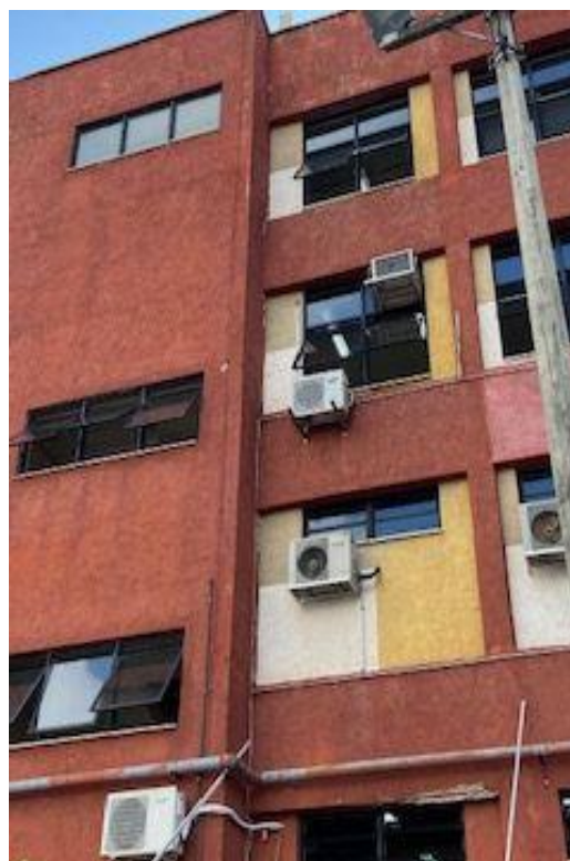
Reparos no reboco da fachada dos fundos, inclusive nas bordas das aberturas, e dilatação entre as paredes (doc. SEI nº 0014895630 - figura 08).
