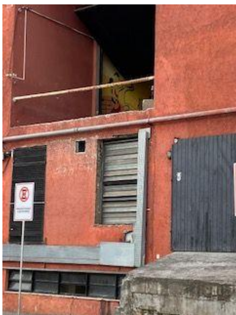
Reparos no reboco da fachada dos fundos, inclusive nas bordas das aberturas (doc. SEI nº 0014895630 - figura 09).
