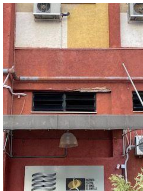
Reparo no reboco (figura 07 no memorial descritivo).
