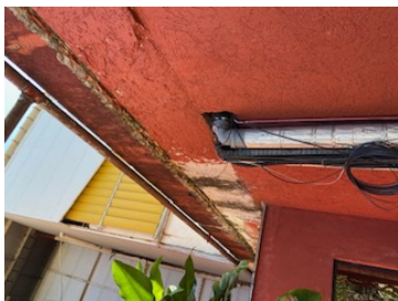
Figura 05 - Parede com rachadura e descolamento da estrutura
