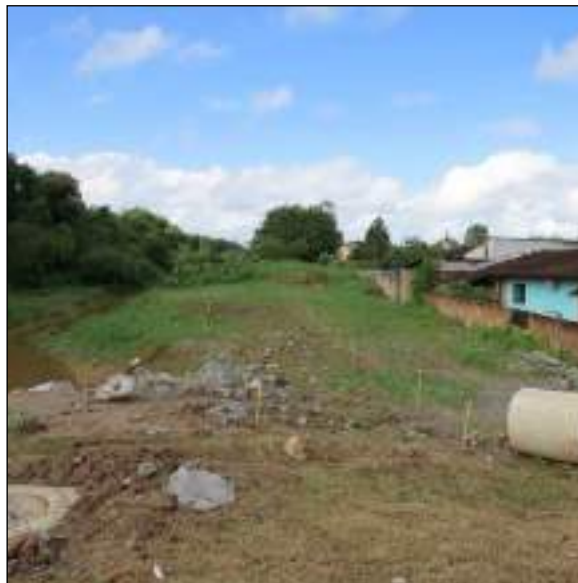
Foto 8.2 - Vista o trecho onde a ocupação residencial ocorre bem próximo do canal a ser dragado, inclusive sobre a faixa integrada pela ADA do projeto.
