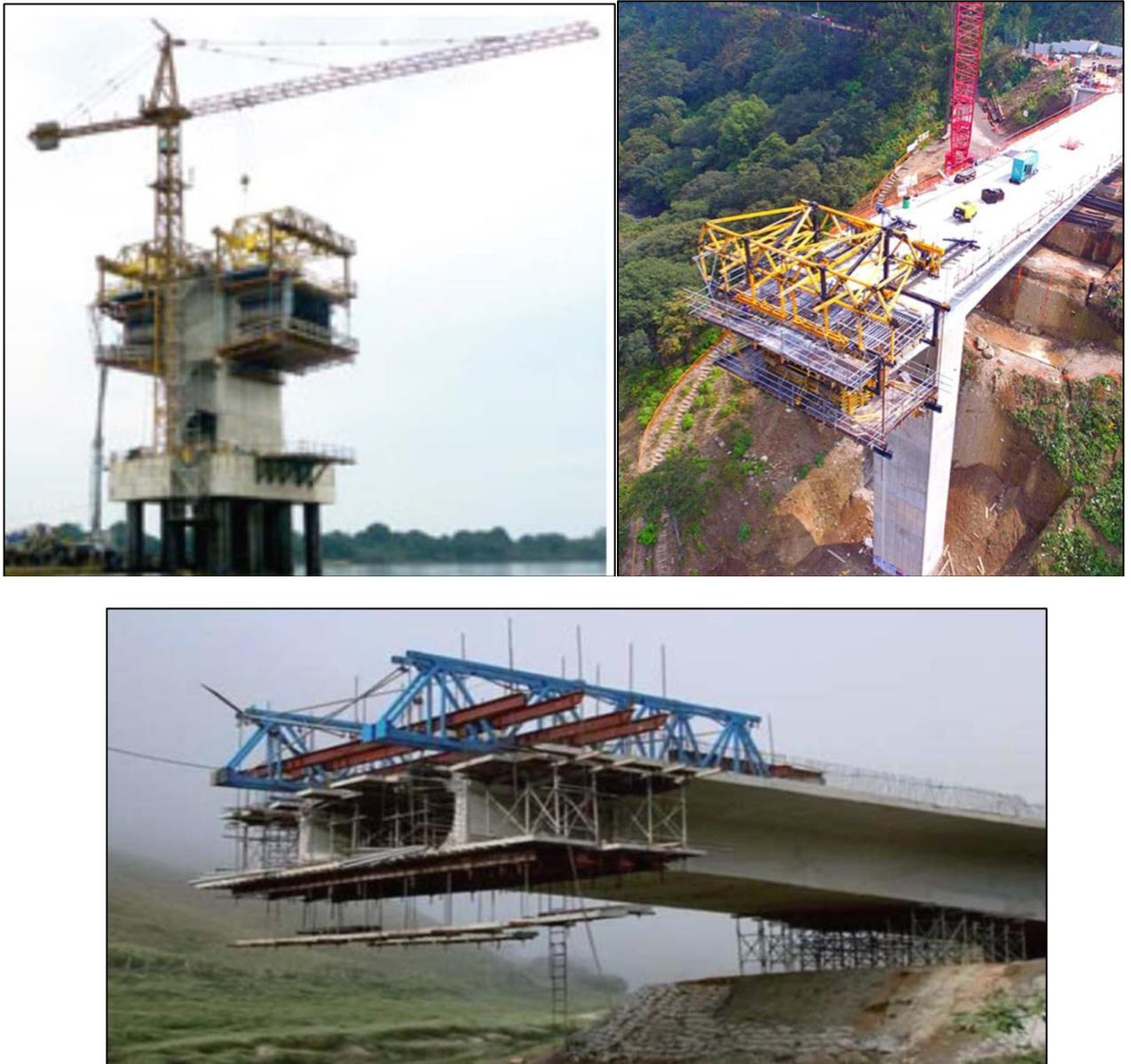
Figura 6 - FOTO EXECUÇÃO DE BALANÇO SUCESSIVO
