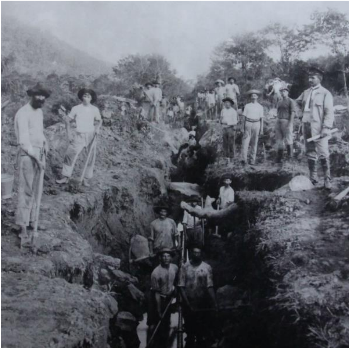
Figura 30 Construção da Rede de Água do Sistema Motucas (s/d) Fonte: Corrêa et al. (2015).
