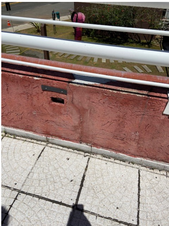
Figura 02 - Reparos na alvenaria
