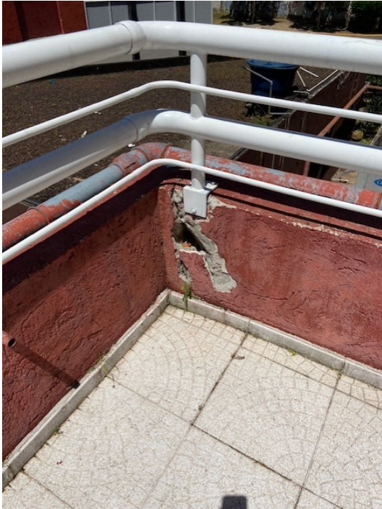
Figura 06 - Base do guarda-corpo em alvenaria
