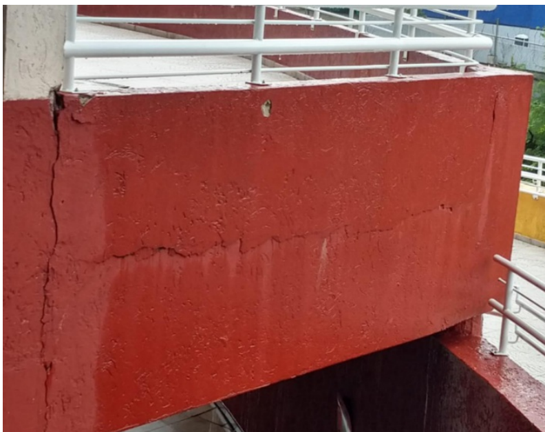
Figura 04 - Guarda Corpo em alvenaria ao lado direito
