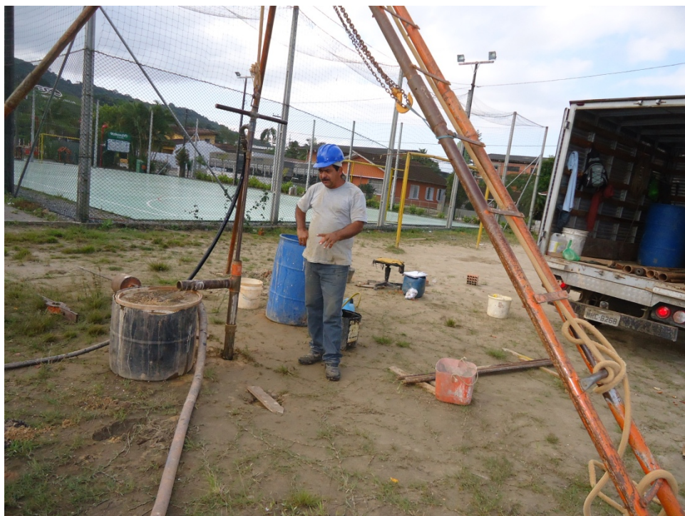
Figura 05 - Execução do furo de sondagem SPT-02
