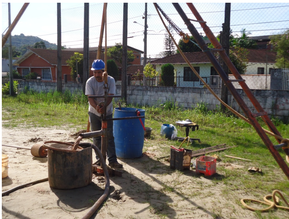
Figura 06 - Execução do furo de sondagem SPT-03
