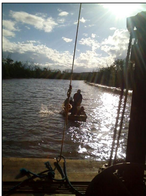
Foto 4 – Barco de apoio e mobilização de equipamento para execução de furos no mangue.
