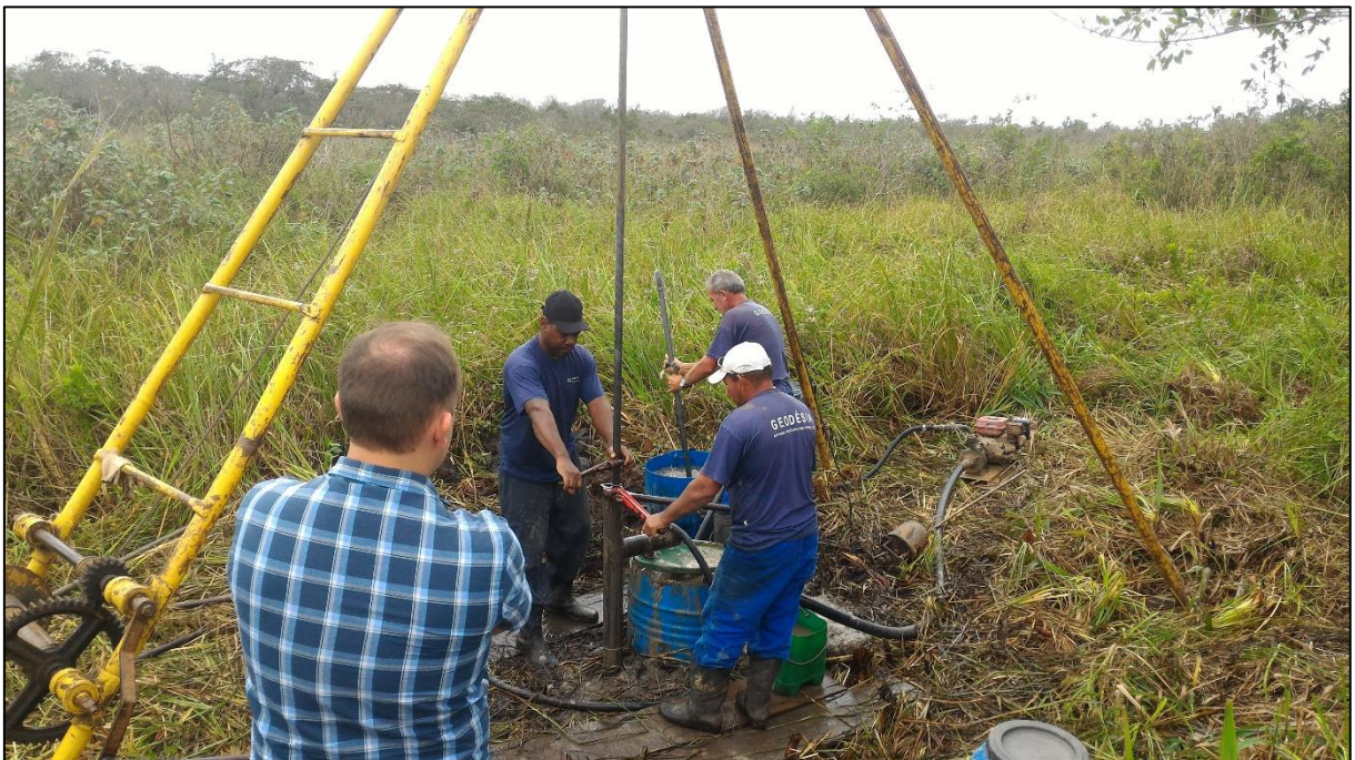
Foto 12 – Membro da fiscalização acompanhando execução do furo NSP-02.
