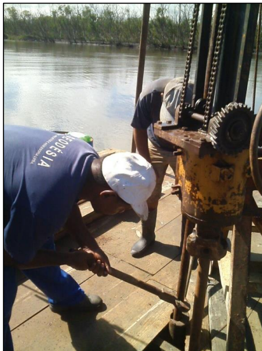
Foto 6 – Execução do furo NSM-02.
