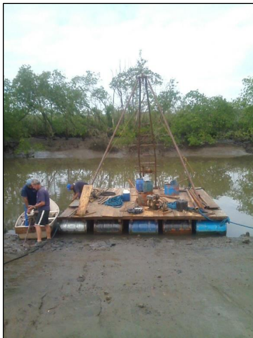
Foto 3 – Mobilização de equipamento para execução de furos no mangue.
