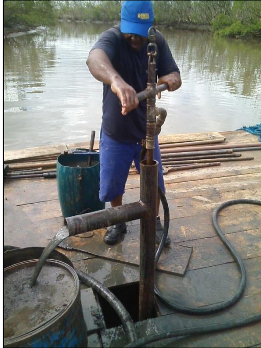
Foto 5 – Execução do furo NSP-06.
