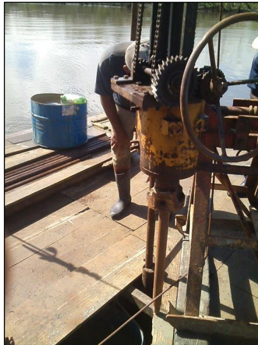
Foto 7 - Execução do furo NSM-02.
