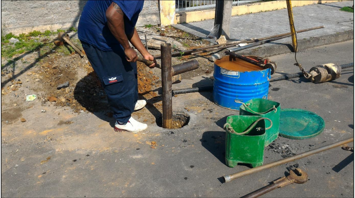
Foto 9 – Execução do furo NSP-11A.
