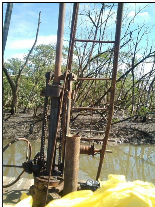
Foto 8 – Equipamento para sondagem rotativa no furo NSM-02.
