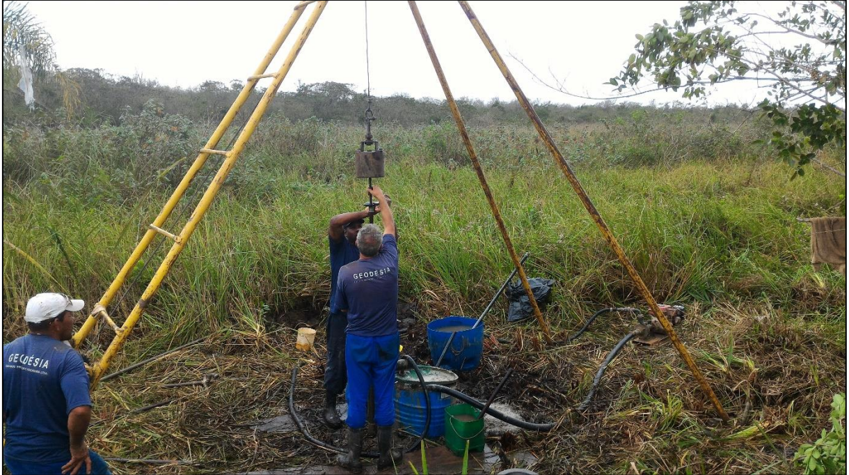
Foto 13 – Execução do furo NSM-02.
