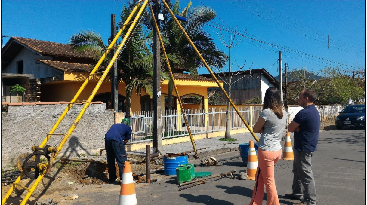
Foto 11 – Membros da fiscalização acompanhando a execução do furo NSP-11A.
