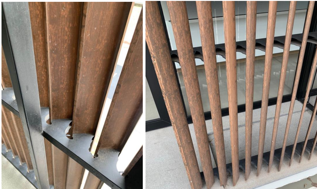
Imagem 12 – Modelo de brise a ser executado
