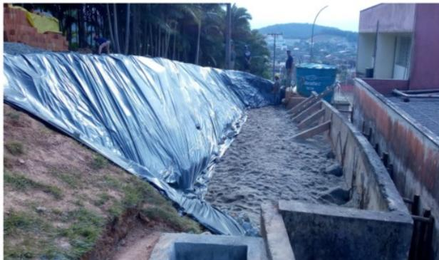
Situação em março 2020 - remoção de terra, proteção do talude, aplicação de drenos para alívio da pressão hidrostática e escoramento do muro de concreto.
