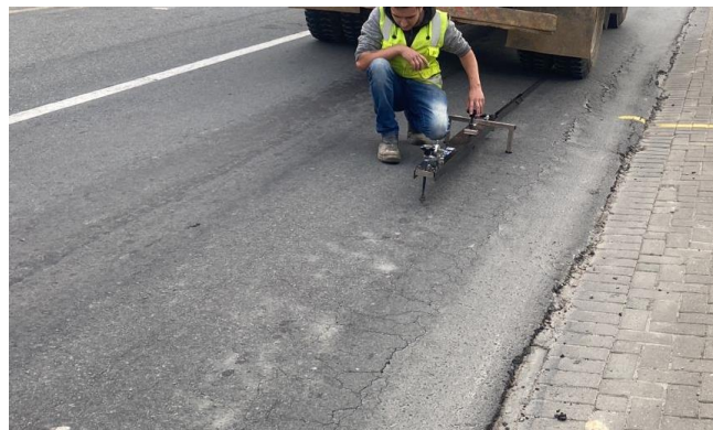
Figura 12.4 - Reflexão das trincas sobre o recapeamento recente.
