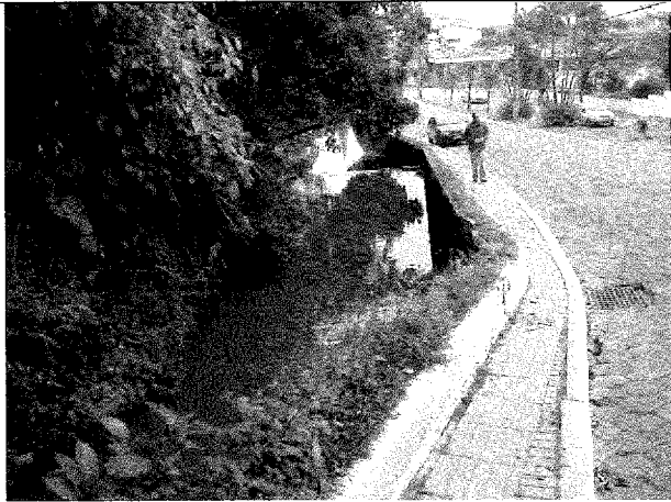
Foto 44 – Registro do sistema antigo de captação de água na lateral da rua Pastor Guilherme Rau.
