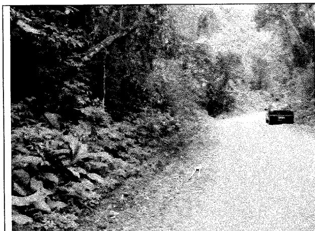
Foto 29– Observação de perfis expostos na lateral da
