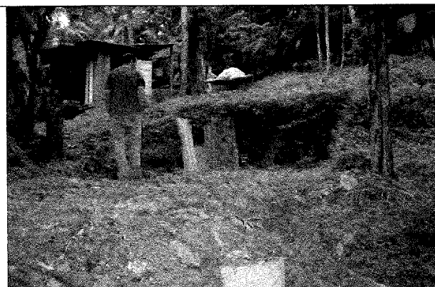
Foto 37 – Inspeção visual de solos nas proximidades de residências próximas a Rua Otto Eduardo Lepper.
