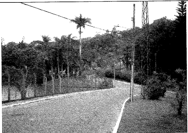
Foto 13 – Estrada pavimentada e infraestruturas dispostas junto à área do Parque Zoobotânico de Joinville.
