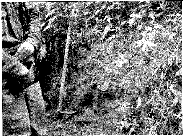
Foto 32 – Constatação de solos revirados devido às antigas obras de implantação da estrada.
