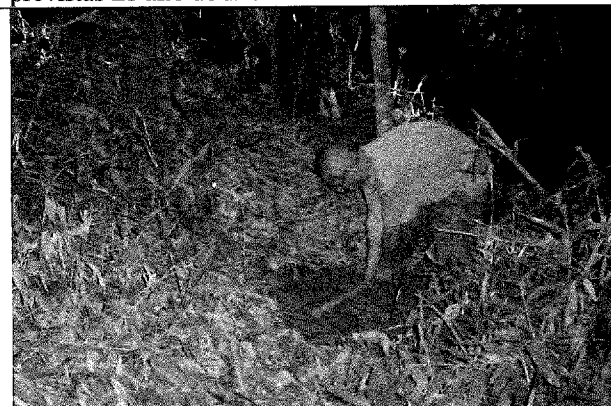
Foto 25 – Execução de raspagem a na faixa delimitada para trilha e deck.
