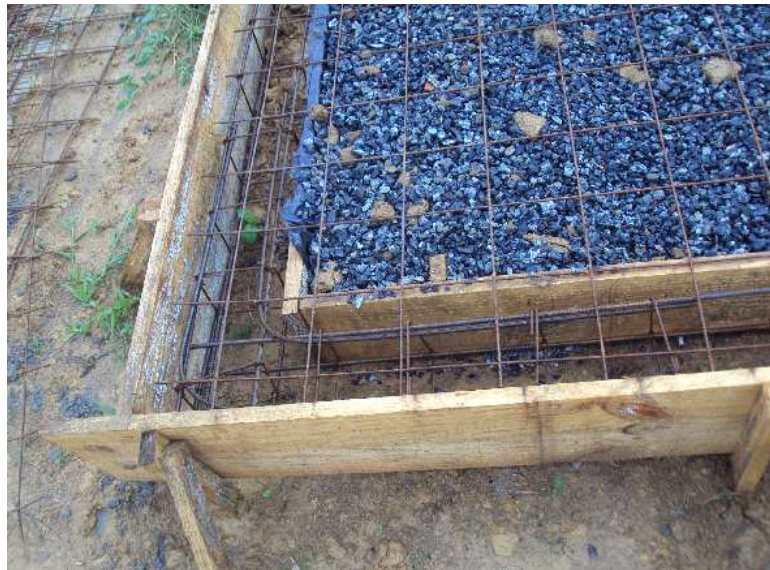
Foto 2 – Execução do radier – tela soldável
