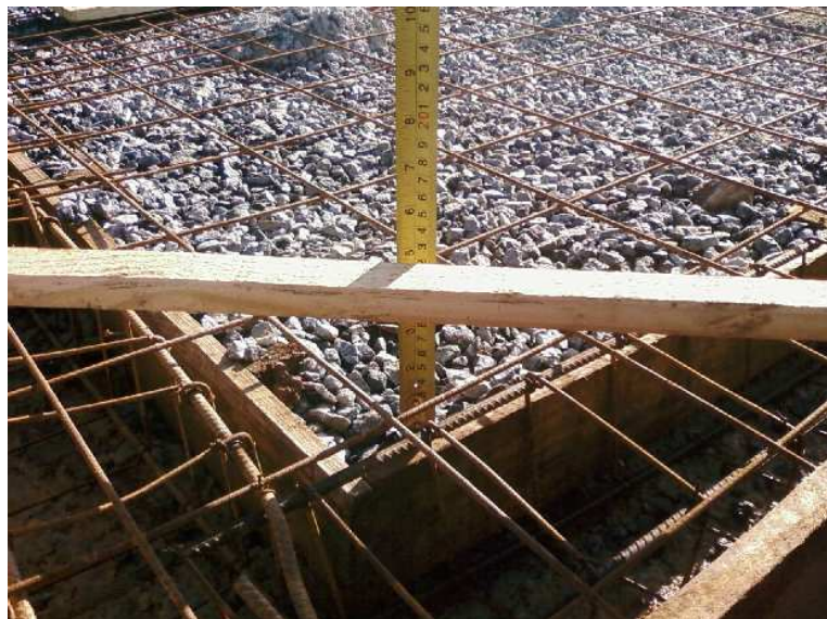
Foto 3 – Execução do radier – fiscalização PMJ
