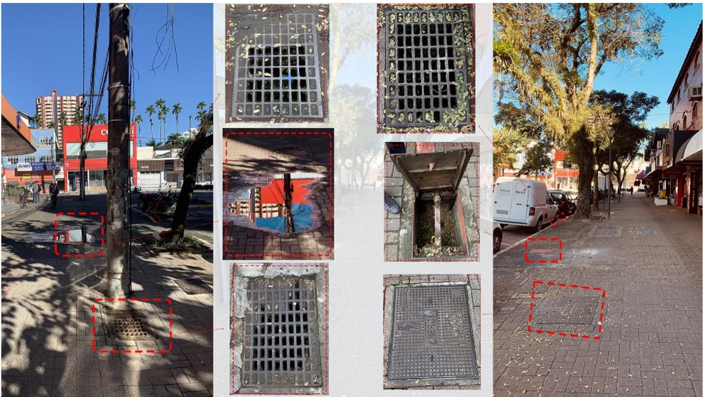
Conforme se percebe nas imagens do mosaico, o transporte de sedimentos é recolhido pelas bocas de lobo e caixas de captação, ficando, em alguns casos, comprometida sua eficiência (água parada). Também, há ligações clandestinas de águas de esgoto junto à rede de drenagem pluvial, constatado durante a visita de campo face ao odor característico da primeira rede.
