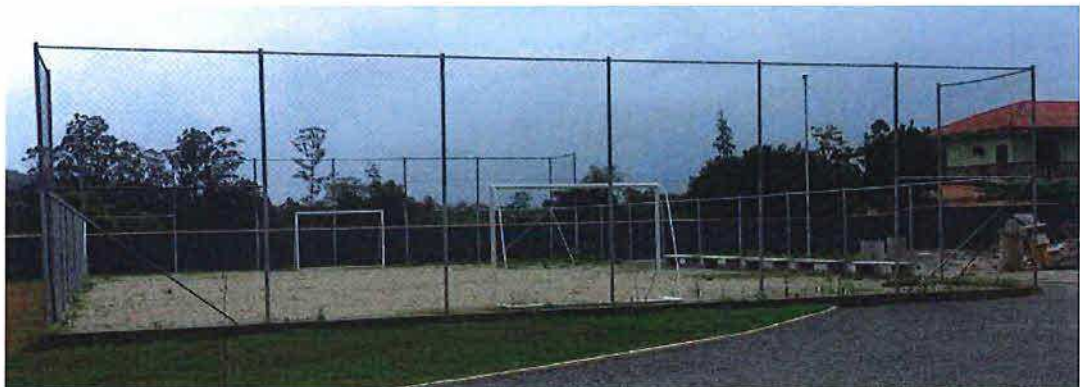
Retirada da cerca metálica da quadra de areia.
