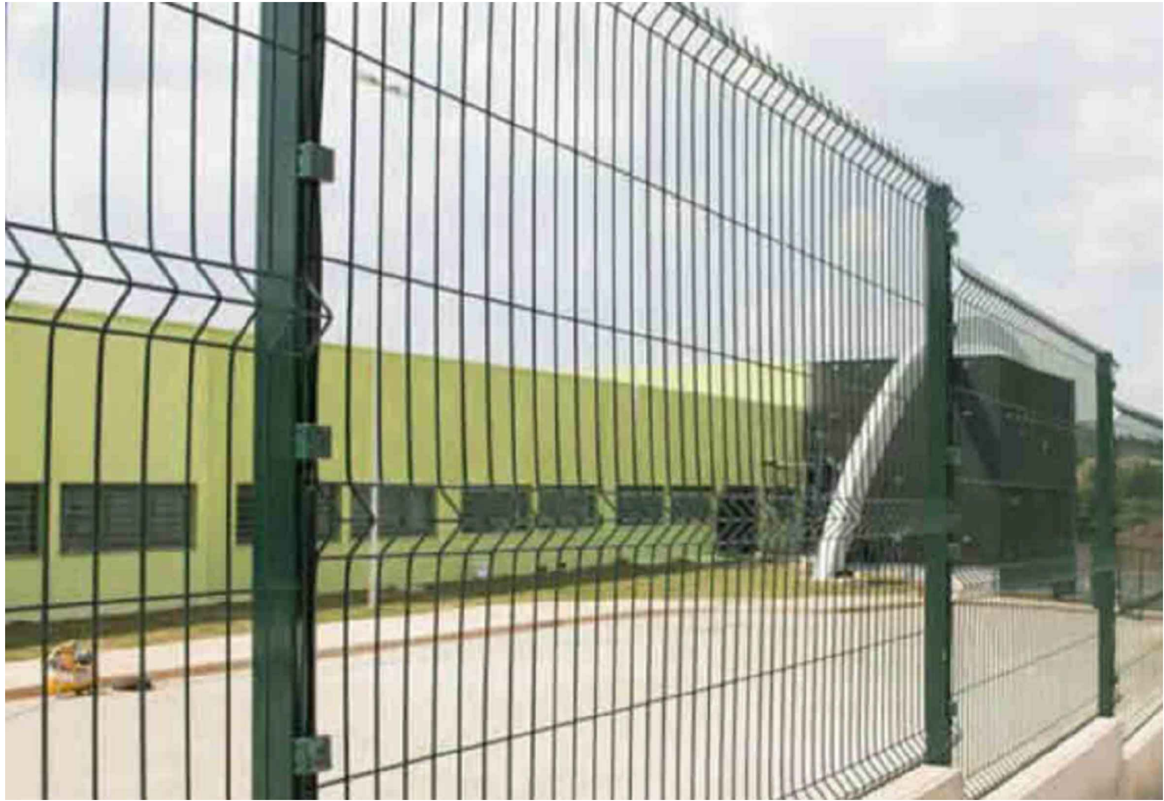
GRADIL DE PROTEÇÃO NA COR VERDE CHUMBADA OU PARAFUSADA EMVIGA BALDRAME CONFORME PROJETO ESPECÍFICO Tela gradil revestida com PVC na - COR RAL 6003, e pantone 7763c - ref. Pantone
