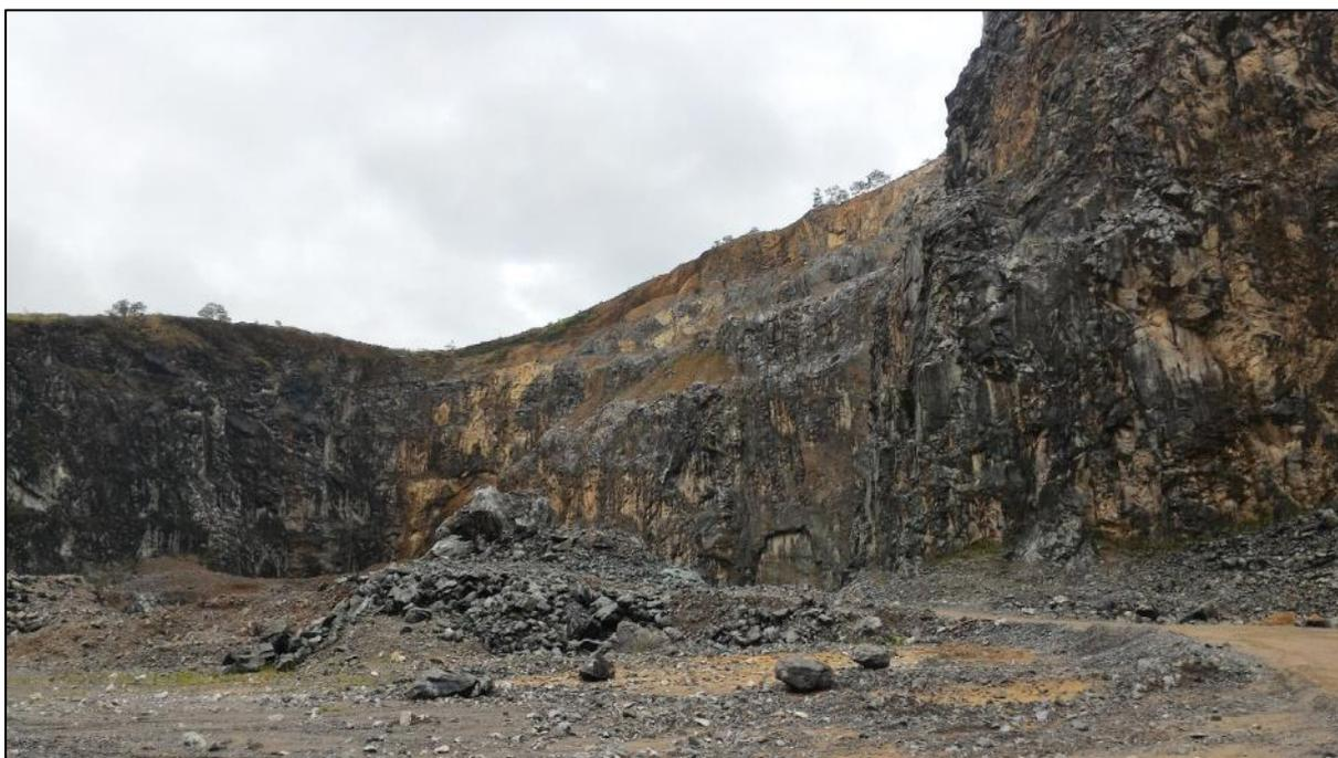
Figura 34 - Fonte de rocha e solo de aterro (parte superior) na jazida da Pedreira Rio Zoada. (relatório I-OAESV-R-R0/16-16-IV)
