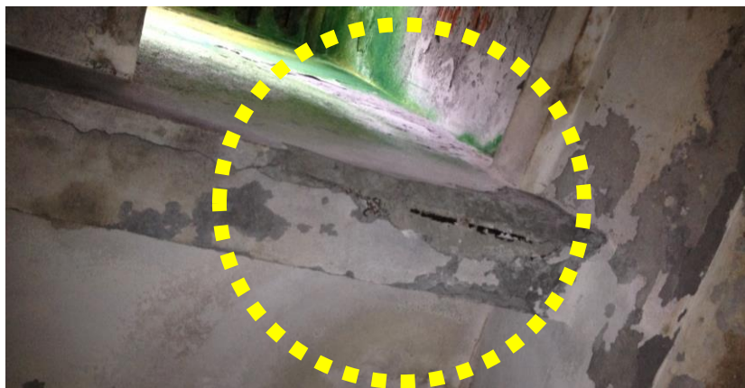
Imagem 01 – Armadura exposta no fundo da caixa d'água Fonte: Amunesc, abril de 2016
