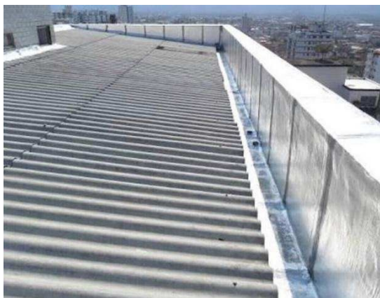
Calha de concreto impermeabilizada com manta aluminizada.
