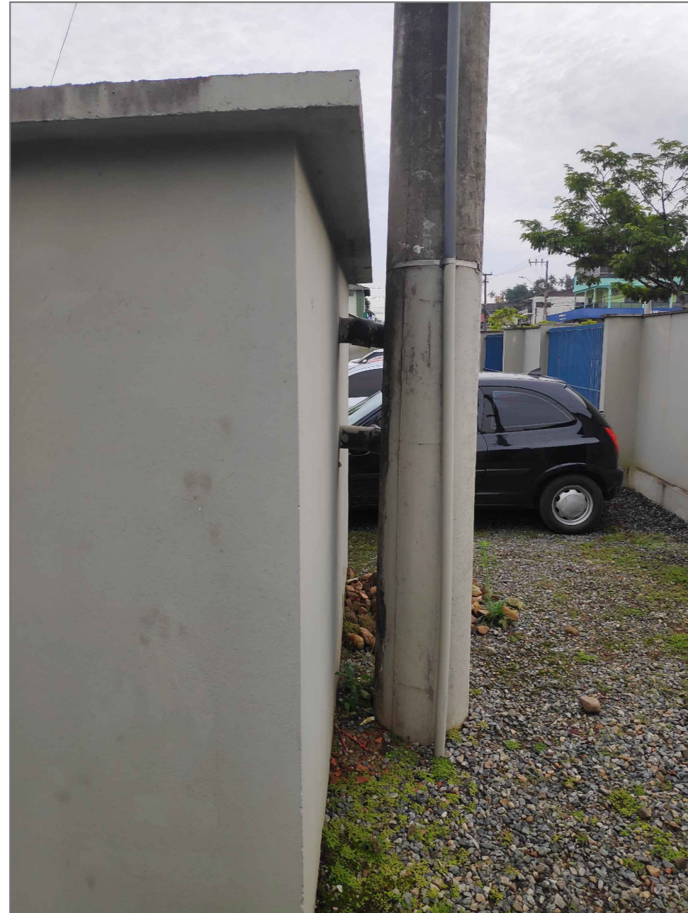
Detalhe da distância da cabine para o poste mínimo 15 cm
