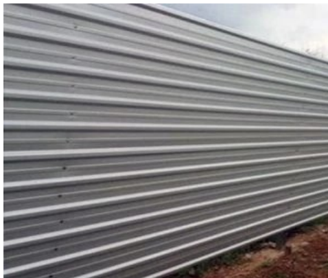
TAPUME EM TELHA METÁLICA
