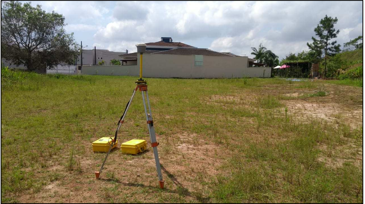
FIGURA 4 – GPS BASE EXECUTANDO O LEVANTAMENTO TOPOGRÁFICO
